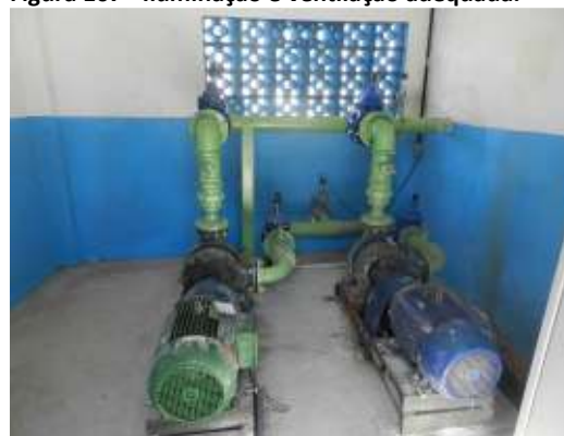
Figura 109 - Conjunto motor-bomba.
