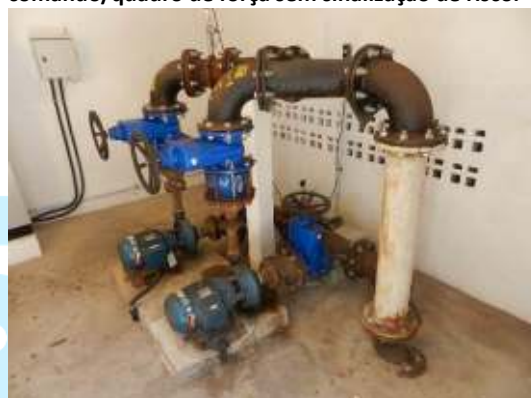
Figura 53 - Conjunto motor-bomba.
