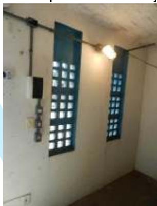
Figura 87 - Iluminação e ventilação adequada.
