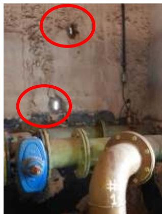
Figura 62 - Aberturas na estrutura física da EEAT de Gurigica.
