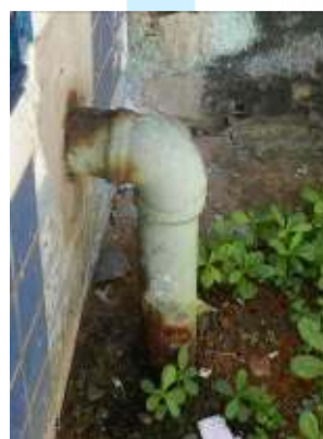
Figura 159 - Tubulação corroída.
