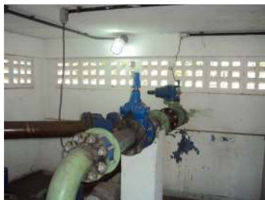
Figura 22 – Iluminação e ventilação adequada.
