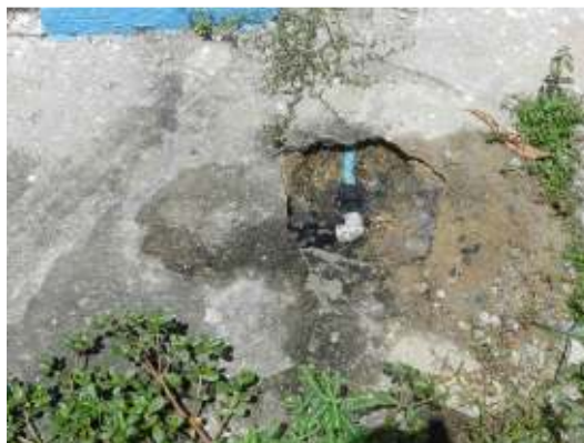
Figura 157 – Ramal rompido.
