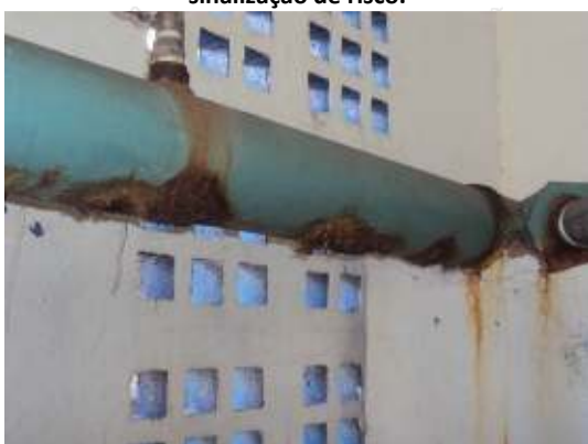
Figura 39 - Tubulação corroída.
