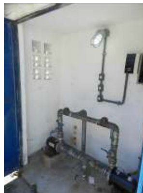
Figura 103 - Iluminação e ventilação adequada.
