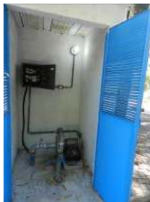
Figura 113 - Iluminação e ventilação adequada.
