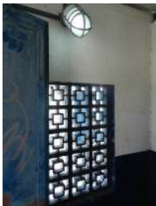
Figura 160 - Iluminação e ventilação adequadas.
