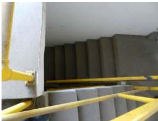
Figura 122 - Escada de acesso.
