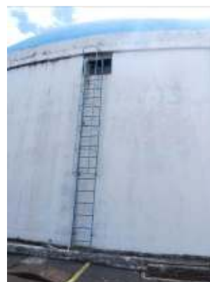
Figura 55 - Escada de acesso.
