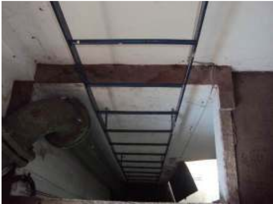
Figura 9 - Escada de acesso.
