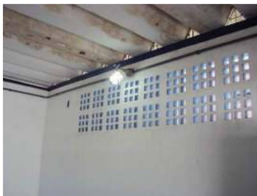
Figura 36 - Iluminação e ventilação adequada.
