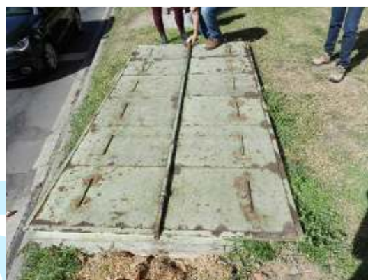
Figura 48 - Ausência de Ventilação.
