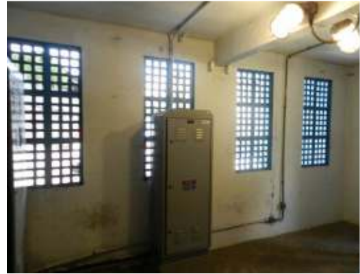
Figura 72 - Iluminação e ventilação adequadas.
