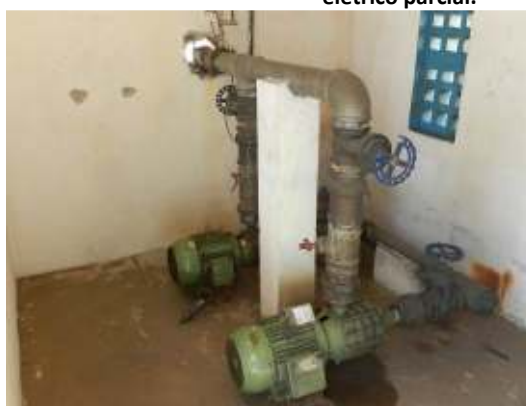
Figura 89 - Conjunto motor-bomba.
