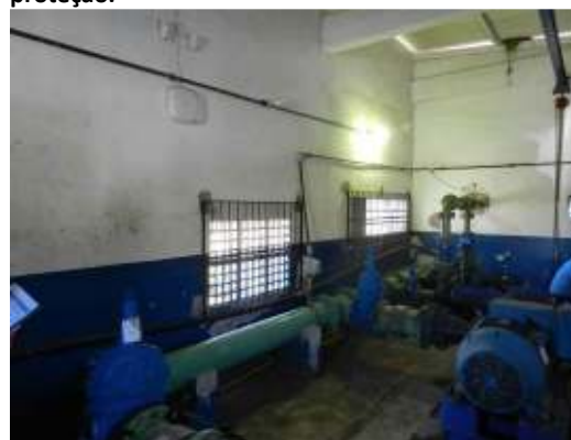
Figura 172 - Iluminação e ventilação adequadas.
