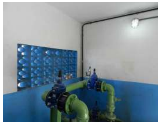
Figura 107 - Iluminação e ventilação adequada.
