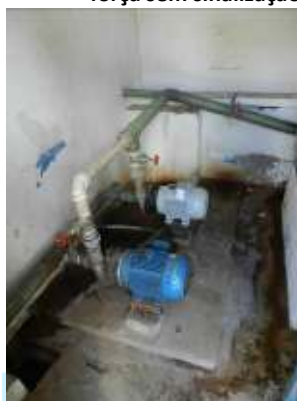
Figura 144 - Conjunto motor-bomba.
