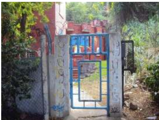
Figura 12 - Ausência de Identificação.
