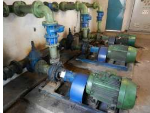
Figura 74 - Conjunto motor-bomba.
