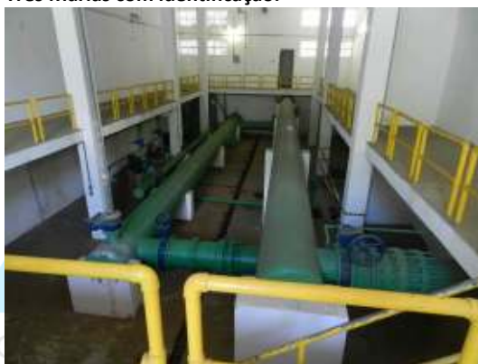
Figura 130 - Iluminação e ventilação adequada.
