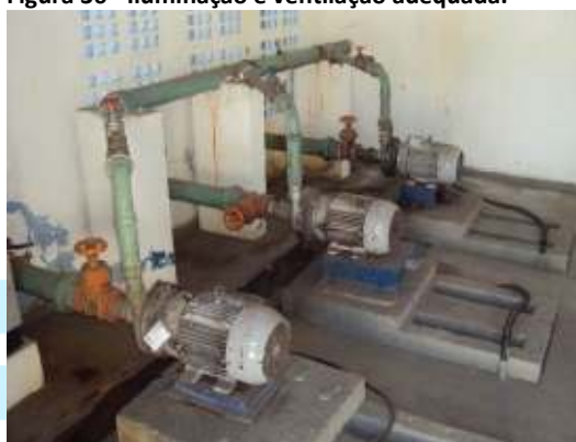
Figura 38 - Conjunto motor-bomba.
