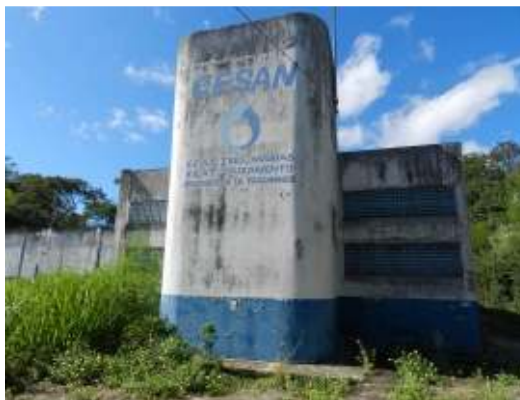
Figura 128 – Local em que está instalada a EEAT Três Marias com identificação.
