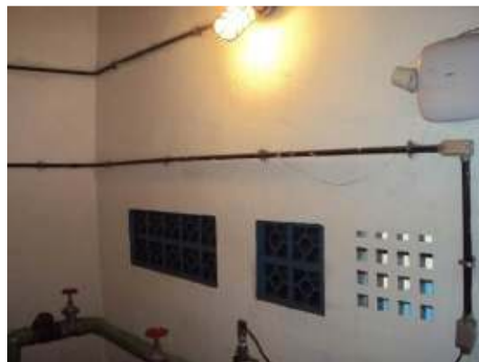
Figura 31 – Iluminação e ventilação adequada.
