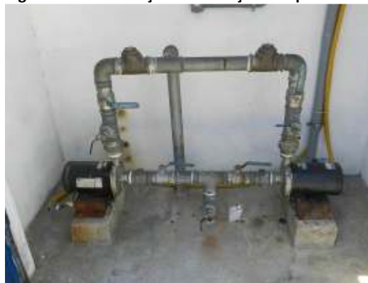
Figura 105 - Conjunto motor-bomba.
