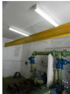
Figura 80 - Iluminação e ventilação adequadas.
