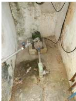
Figura 58 – Ausência de bomba reserva instalada. Figura 59 - Portão de acesso a EEAT danificado.
