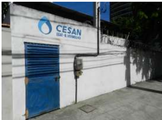
Figura 50 - EEAT Barro Vermelho com identificação.
