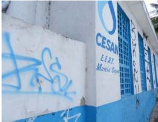
Figura 71 - EEAT Marechal Campos identificada.
