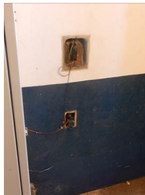
Figura 6 - Fiação exposta.
