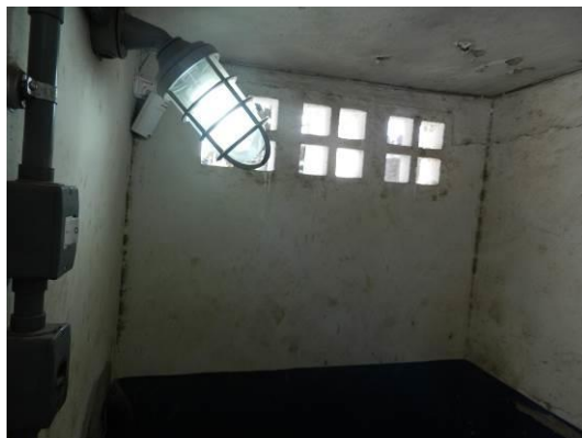
Figura 9 - Iluminação e ventilação razoáveis.
