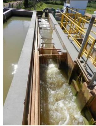
Figura 40 - Calha Parshal.
