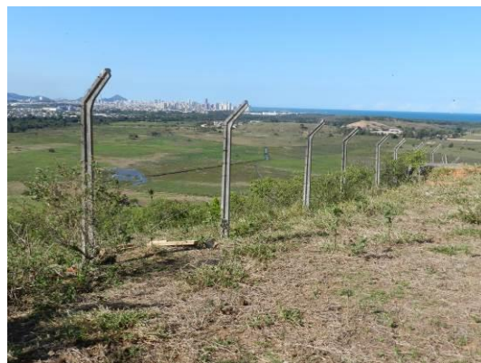
Figura 18 - Entorno sem isolamento.
