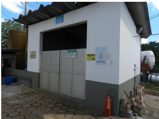
Figura 80 - Sala destinada aos compressores de ar.
