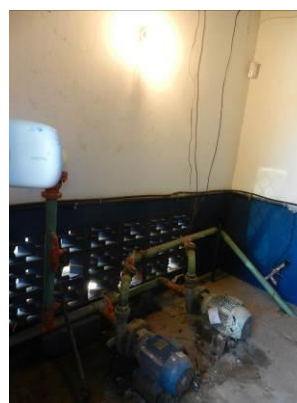
Figura 4 - Iluminação e ventilação adequadas.
