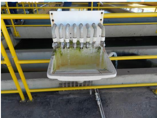
Figura 55 - Local de coleta de água filtrada para análise de turbidez pré-desinfecção.
