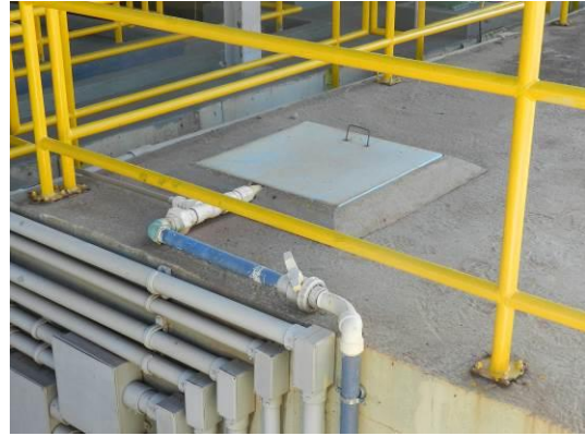
Figura 46 - Local de dosagem de cal.
