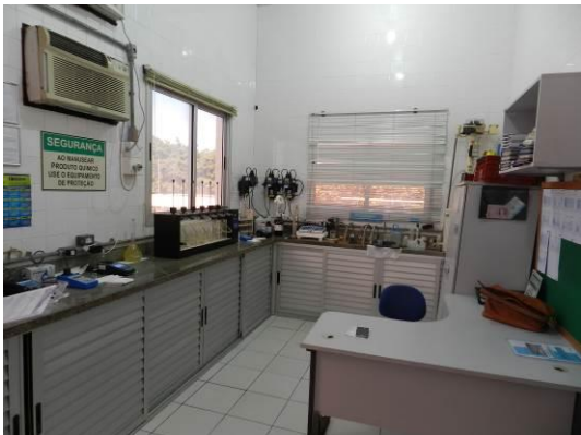
Figura 59 - Laboratório da ETA Caçaroca.
