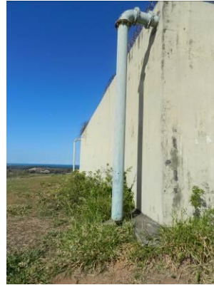
Figura 24 - Tubo extravasor.
