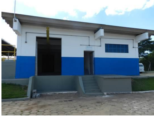
Figura 14 - EEAT Reservatório Barra do Jucu sem identificação.
