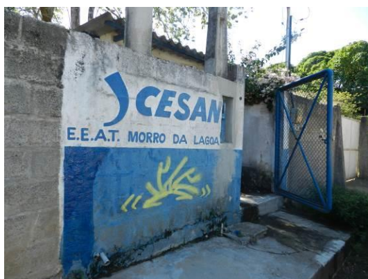
Figura 3 - EEAT Morro da Lagoa com identificação.
