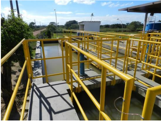
Figura 39 – Pré-sedimentação.
