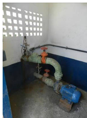
Figura 29 - Ventilação adequada.
