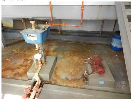
Figura 72 - Dosador e bomba dosadora de sulfato de alumínio.
