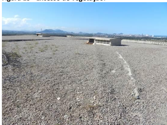
Figura 21 - Laje de cobertura sem guarda-corpo.
