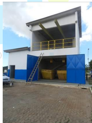
Figura 56 - Unidade de desaguamento do lodo.
