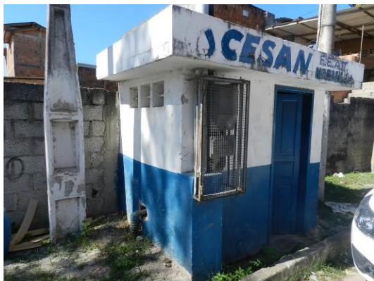
Figura 8 - EEAT Normília com identificação comprometida.
