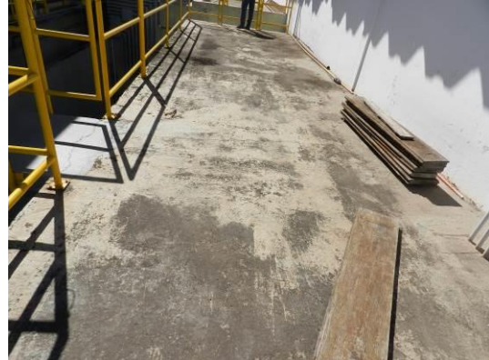
Figura 48 - Tanque de contato.
