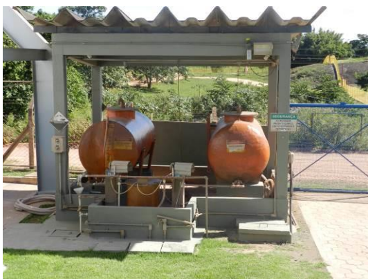
Figura 76 - Depósito de ácido fluossilícico.
