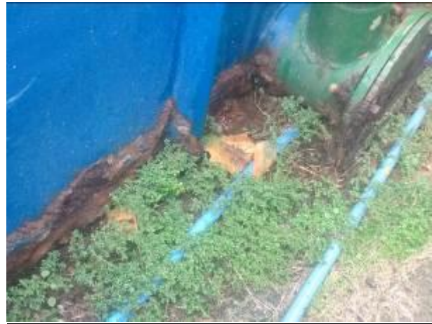
Figura 13 - Base da estrutura da ETA.
