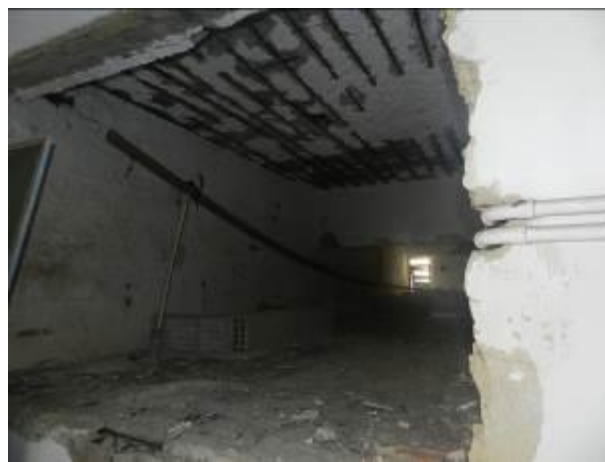
Figura 22 - Armadura exposta.
