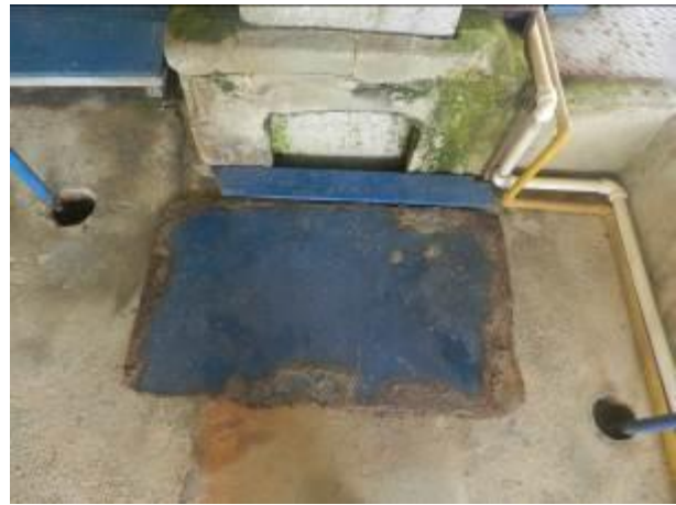
Figura 16 - Tamba na ETA.
