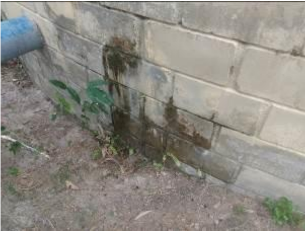
Figura 11 – RAT Semi-enterrado da ETA.
