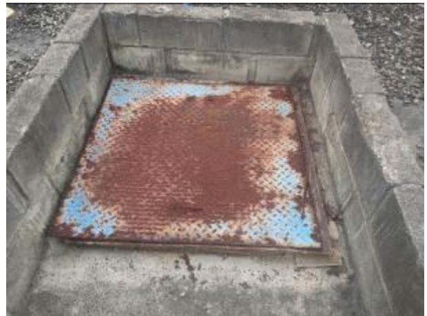
Figura 10 - Tampa do reservatório da ETA.
