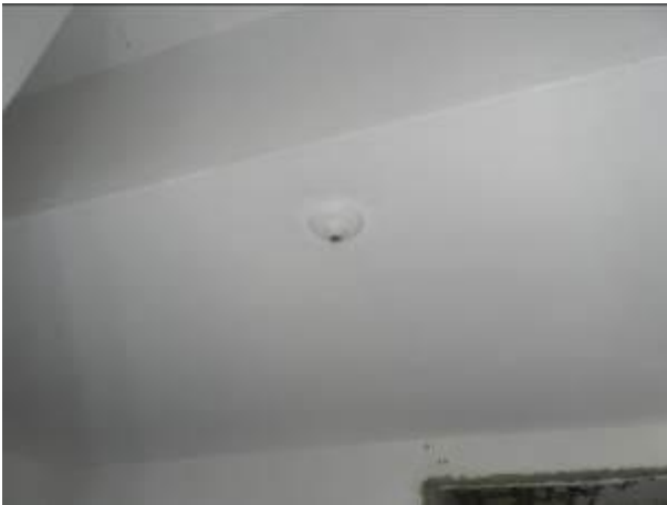
Figura 23 - Sala de depósito de cal hidratada.
