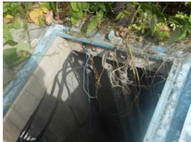
Figura 4 - Poço da EEEB A.
