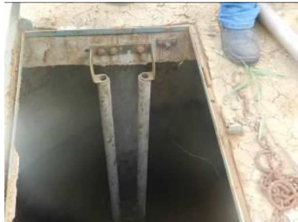
Figura 2 - Poço da EEEB C.
