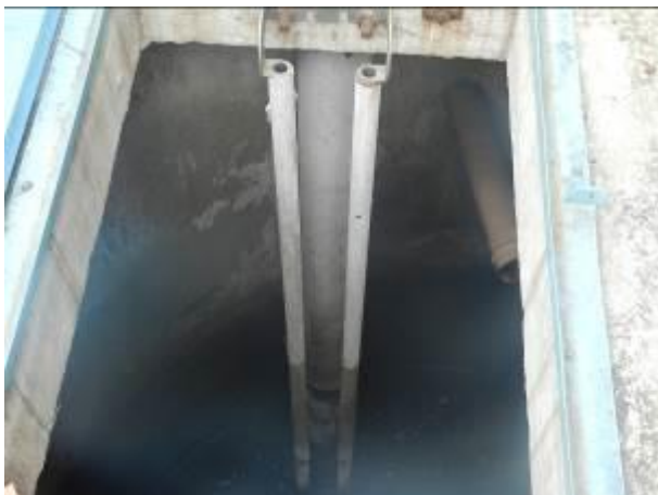
Figura 5 - Poço da EEEB da ETE.
