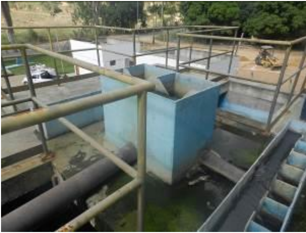
Figura 10 - Distribuidores do reator.
