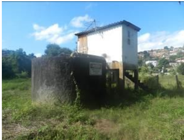
Figura 2 – Captação Vila Verde.
