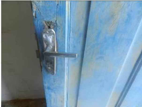
Figura 5 – Captação Vila Verde.
