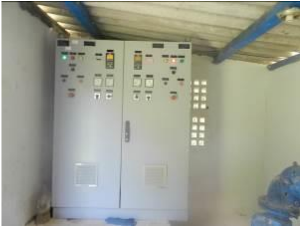
Figura 3 – Captação Vila Verde.
