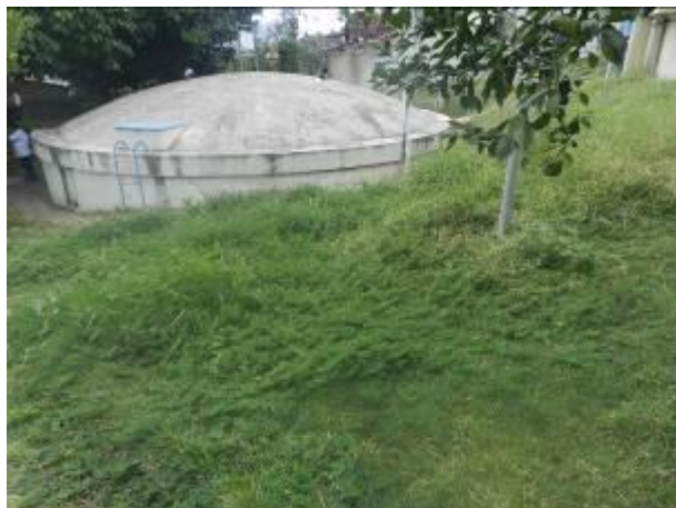
Figura 18 – ETA Pancas - Sede.
