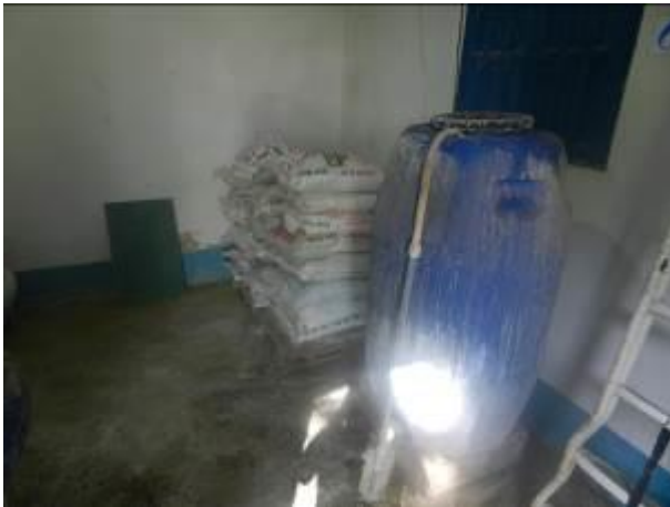
Figura 13 - Ácido Flúorsilícico - ETA Vila Verde.
