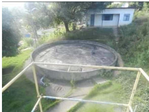
Figura 19 – ETA Vila Verde.
