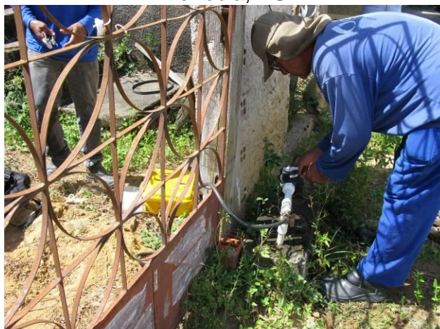
Figura 4 - Equipamento de medição instalado no Ponto 04 - Nova Venécia, ES
