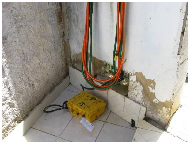
Figura 3 - Equipamento de medição instalado no Ponto 03 - Município de Nova Venécia, ES
