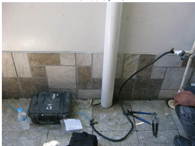
Figura 5 - Equipamento de medição instalado no Ponto 05 - Município de Nova Venécia, ES.
