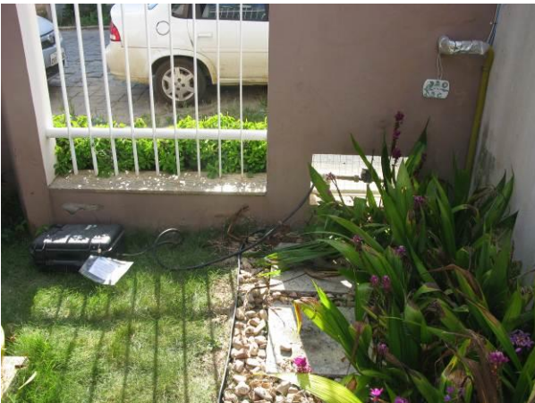
Figura 9 – Equipamento de medição instalado no Ponto 09 – Município de Nova Venécia, ES.
