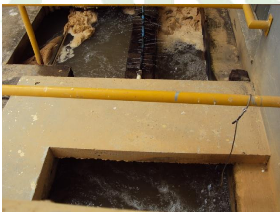
Figura 9: Unidade de mistura rápida
