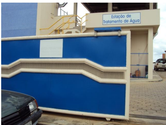
Figura 7: Acesso à ETA
