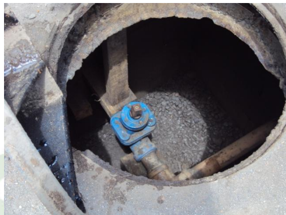
Figura 22: Descarga da rede no bairro Aeroporto
