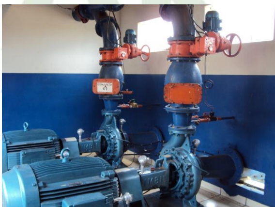
Figura 5: Conjuntos motobomba
