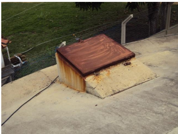
Figura 21: Tampa de inspeção do Reservatório 2
