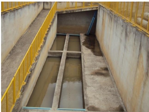
Figura 3: Caixa desarenadora
