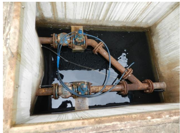
Figura 5 – EEEB II - ETE Piaçú.
