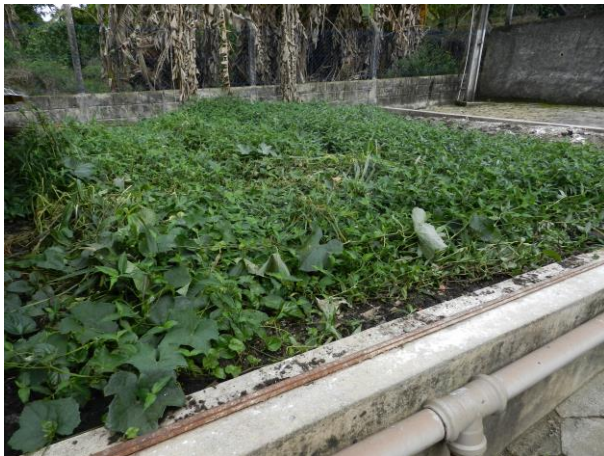
Figura 6 - Leito de secagem da ETE Muniz Freire Sede.
