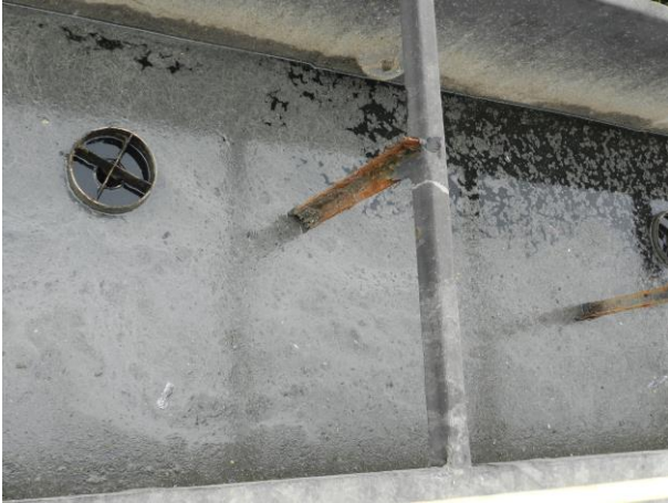
Figura 10 - Reator UASB + Biofiltro.
