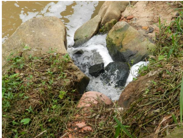
Figura 8 - Ponto de Lançamento da ETE Muniz Freire Sede.
