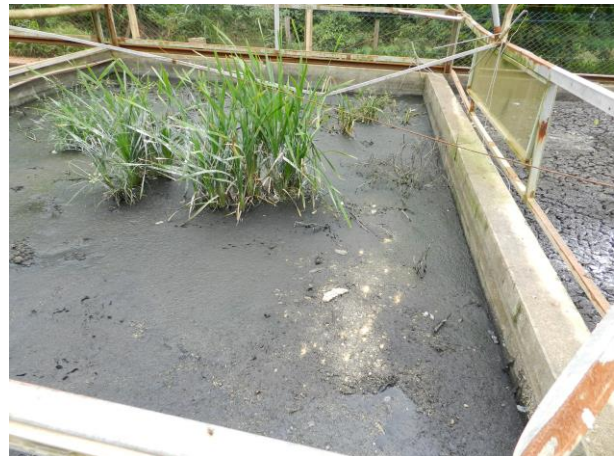
Figura 7 – Leito de secagem da ETE Piaçú.
