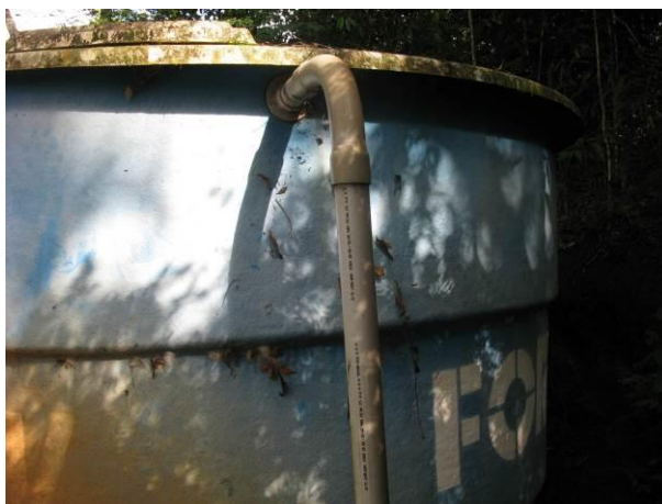
Figura 11 - Reservatório Vila Nova.
