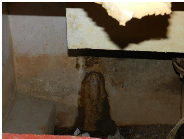
Figura 4 - ETA Marechal Floriano.
