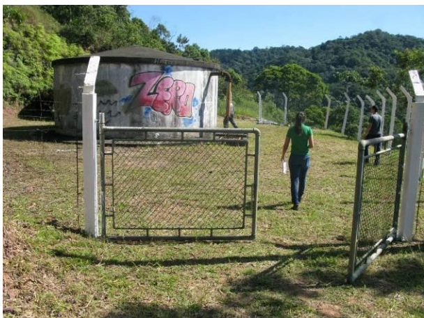
Figura 8 - Reservatório Marechal Floriano.
