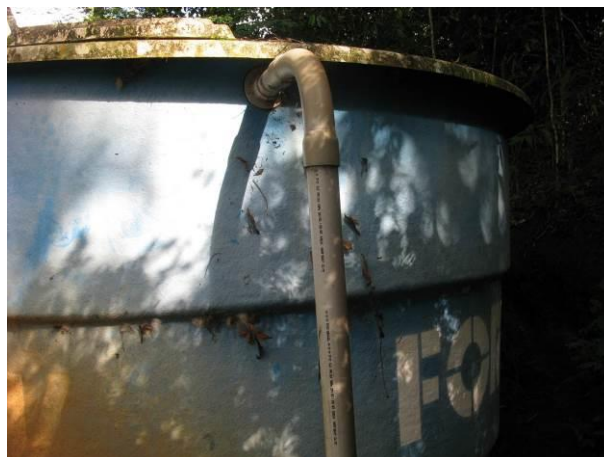
Figura 9 - Reservatório Vila Nova.
