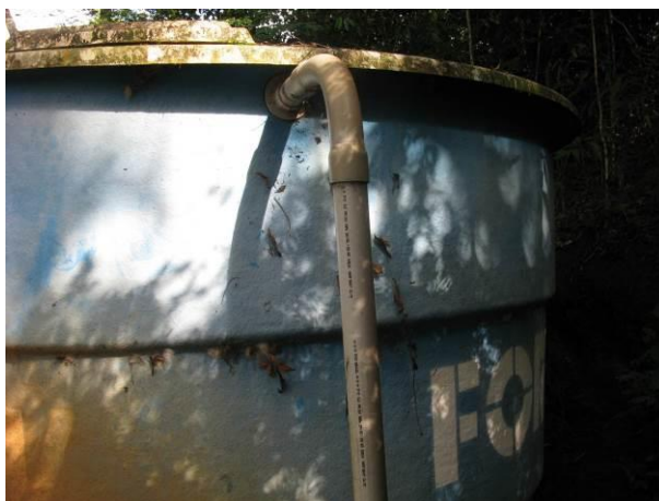
Figura 12 - Reservatório Vila Nova.
