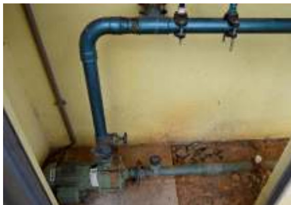
Figura 50 - Conjunto motor-bomba.
