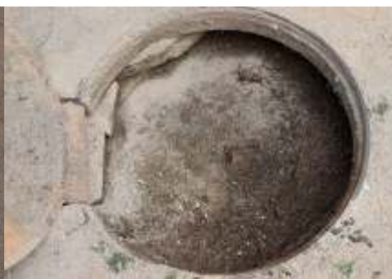
Figura 75 - Descarga 2 assoreada.
