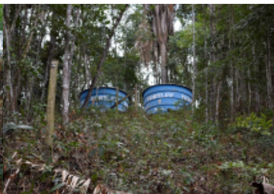
Figura 64 – Reservatórios de 15000 litros.
