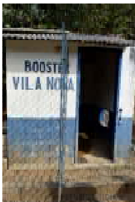
Figura 44 - EEAT Vila Nova.
