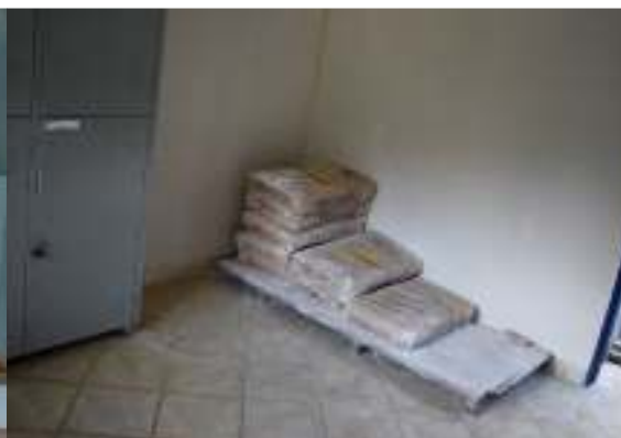
Figura 21: Armazenamento de Cal.
