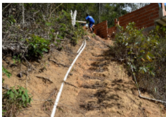
Figura 68 - Percurso de acesso ao reservatório de 10000 litros.
