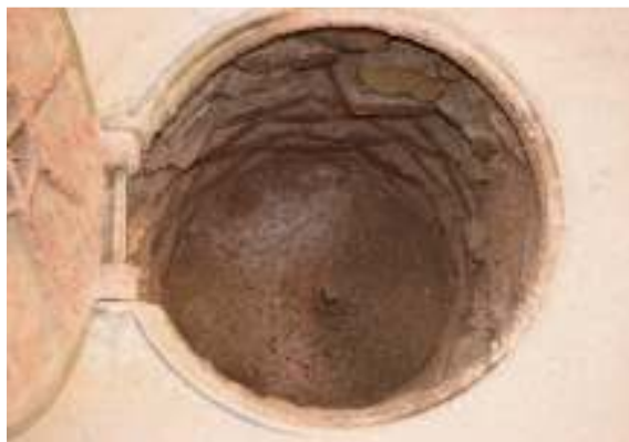
Figura 72: Descarga 1 assoreada.
