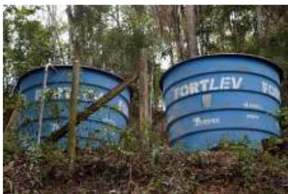
Figura 67 - Reservatórios de 15000 litros sem isolamento completo.
