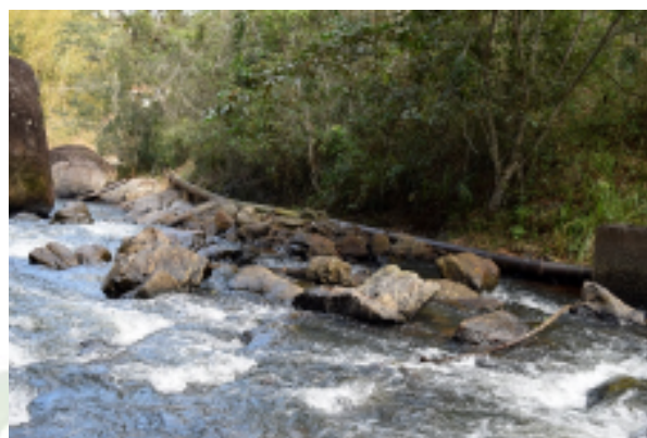
Figura 2 – Entorno da captação sem identificação e sem isolamento.
