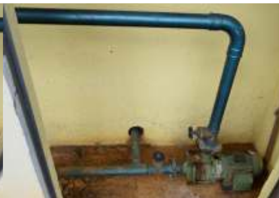
Figura 51 - Conjunto motor-bomba.
