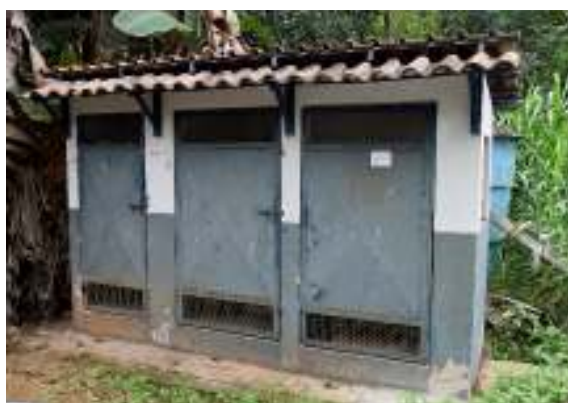
Figura 53 - Booster Darly Canal.
