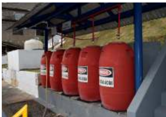
Figura 35 - Depósito de ácido fluossilícico.
