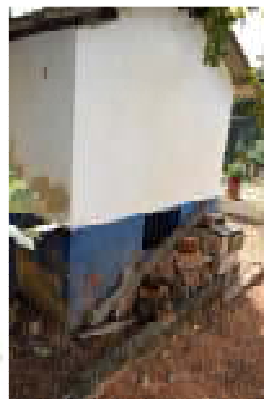
Figura 47 - Resíduos de obra no entorno da EEAT Vila Nova.
