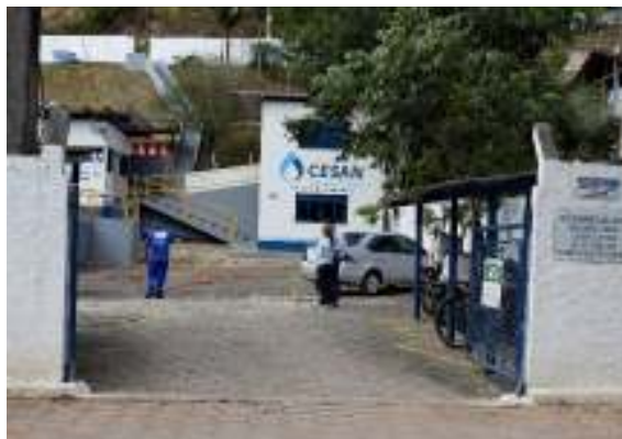
Figura 5 - Entrada da ETA Marechal Floriano Identificada
