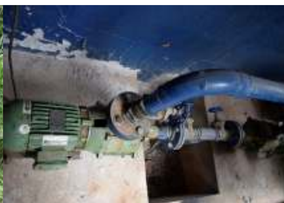
Figura 54 - Conjunto motor-bomba.
