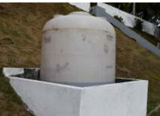
Figura 36 - Depósito de sulfato de alumínio.
