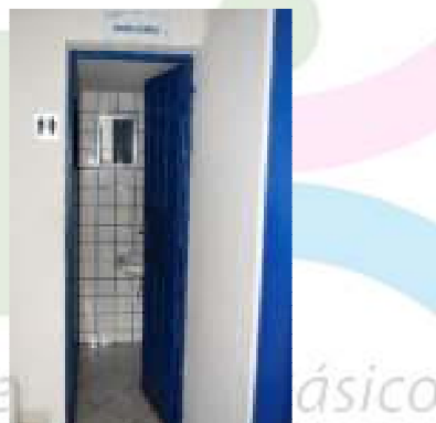
Figura 33 – Banheiro da ETA Marechal Floriano.
