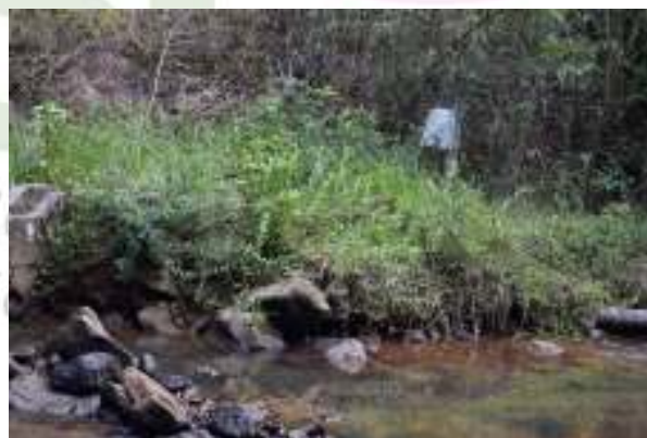
Figura 4 - Excesso de vegetação no entorno da captação.
