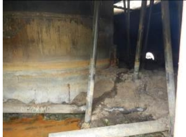
Figura 2 - Interior do Reator desativado.
