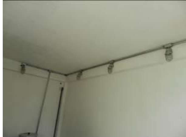
Figura 5 - Casa dos sopradores.
