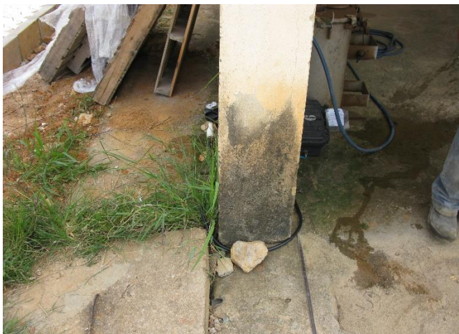
Figura 7- Equipamento de medição instalado no Ponto 06 – Município de Iúna, ES
