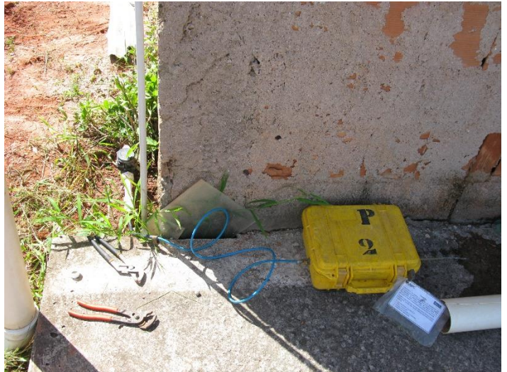
Figura 2 - Equipamento de medição instalado no Ponto 02 - Município de Iúna, ES
