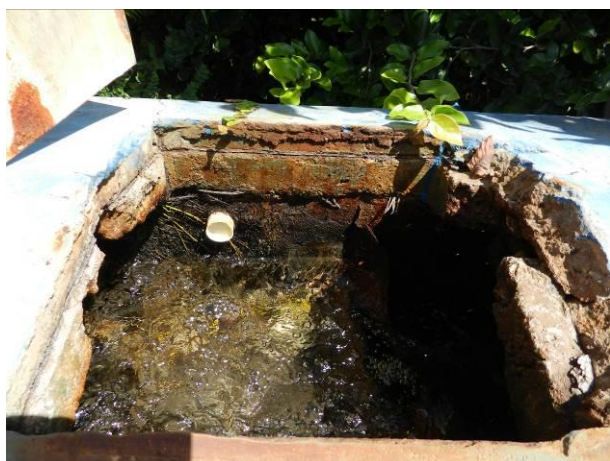
Figura 13 - Necessidade de limpeza e manutenção no canal de entrada da água no reservatório da ETA de Irupi.
