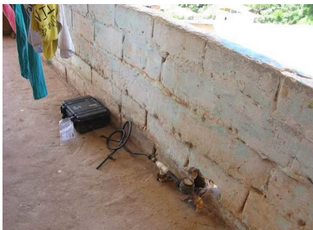
Figura 6- Equipamento de medição instalado no Ponto 05 – Município de Ibatiba, ES
