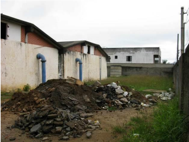
Figura 43 - Reservatório Semi - Enterrado Ipiranga.
