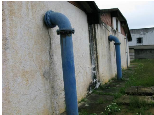
Figura 2 - Reservatório Semi-Enterrado Ipiranga.
