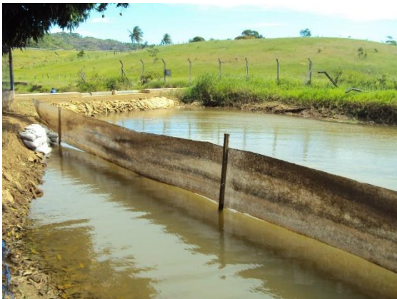
Figura 4: Captação do rio Jabuti.
