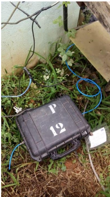
Figura 4 - Equipamento de medição instalado no Ponto 04 - Município de Fundão, ES
