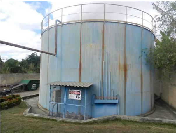
Figura 3 - Reator UASB + Biofiltro.
