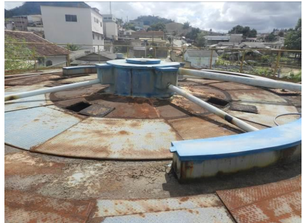
Figura 4 - Reator UASB + Biofiltro.
