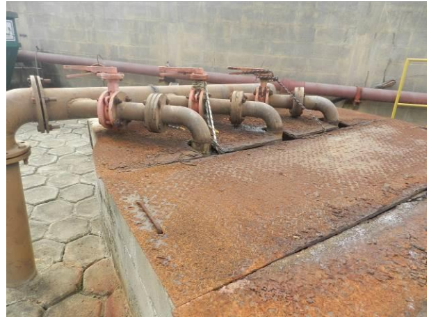
Figura 2 - EEEB da ETE.
