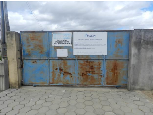
Figura 1 - Portão da ETE.
