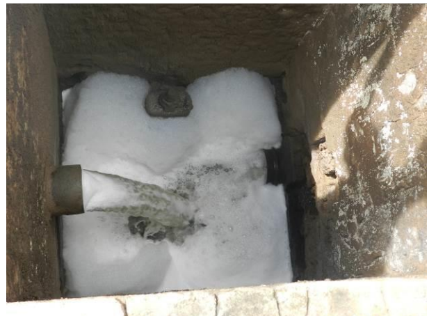
Figura 6 - Excesso de espuma.
