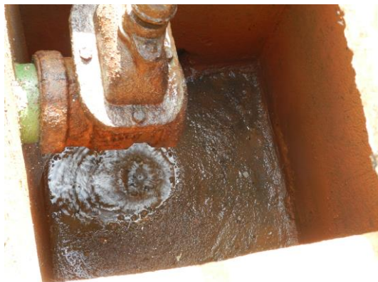
Figura 9 - Válvula de fechamento do floculador.
