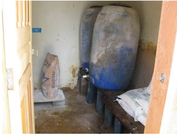
Figura 4 - Tanque de Ácido Fluorsilícico.
