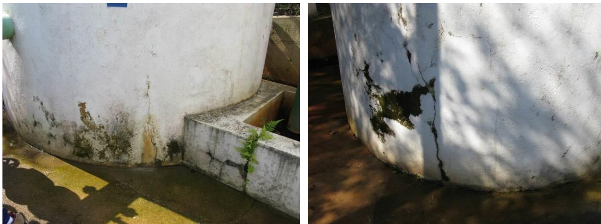
Figura 3 - Filtros da ETA de Dores do Rio Preto
