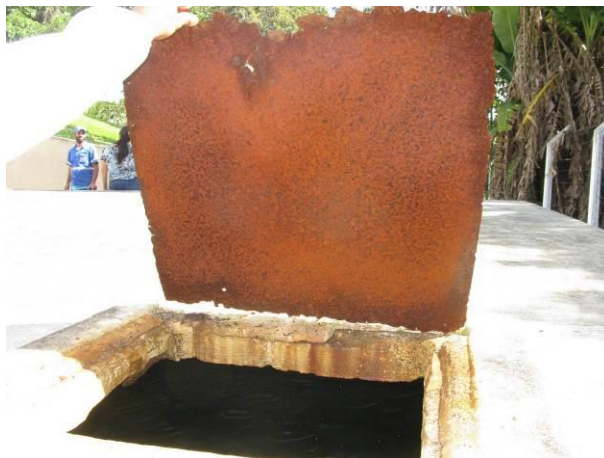
Figura 6 - Reservatório ETA de Dores do Rio Preto.
