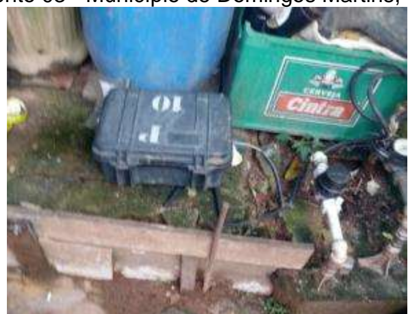
Figura 5 - Equipamento de medição instalado no Ponto 05 - Município de Domingos Martins, ES
