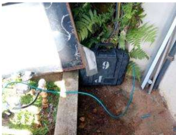
Figura 1 - Equipamento de medição instalado no Ponto 01 - Município de Domingos Martins, ES
