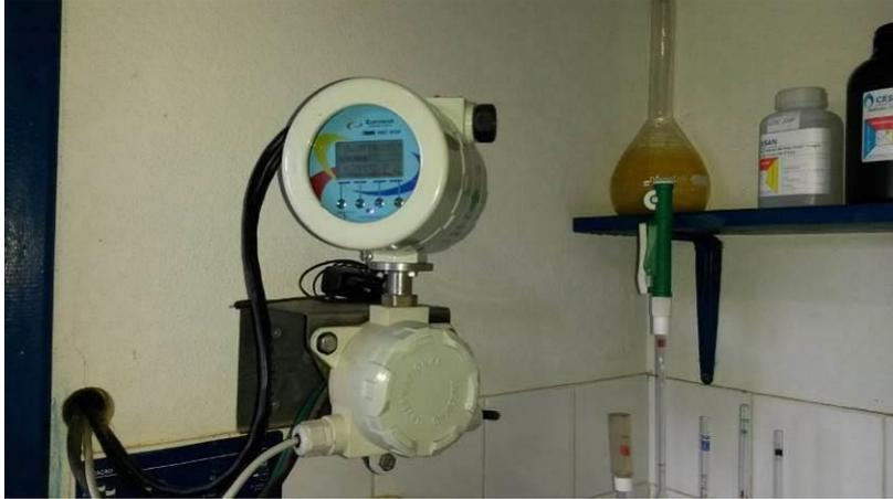
Figura 15 - Medidor de saída não funciona na ETA Ponto Alto.
