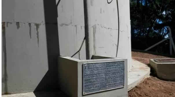
Figura 20 - Há sinais de infiltração no Reservatório Aracê.
