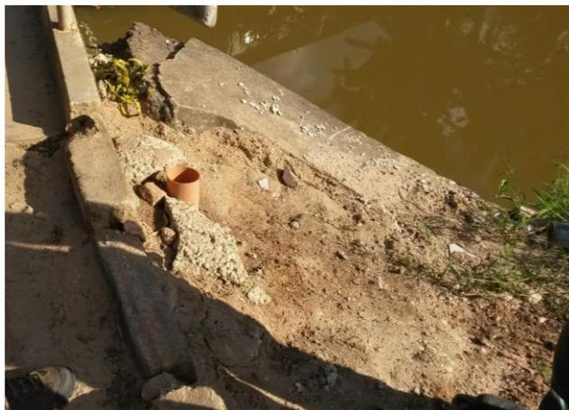
Figura 22 - Descarga vistoriada na Rua Maria Dorotéia Hand (Ponto Alto) está sem tampa de proteção.
