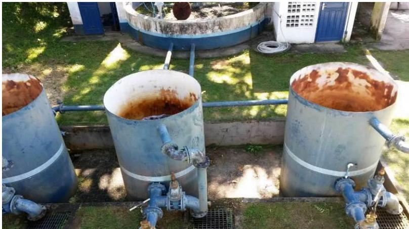
Figura 6 - Há sinais de corrosão nas paredes dos filtros da ETA Aracê.
