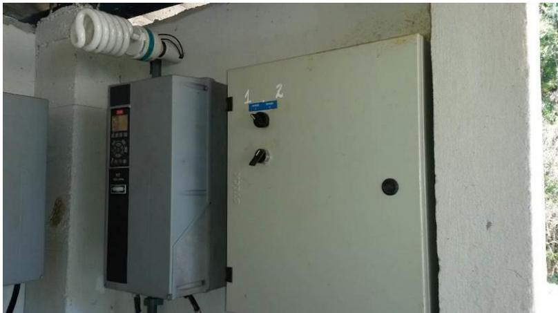
Figura 17 - Ausência de iluminação na EEAT da ETA de Aracê.
