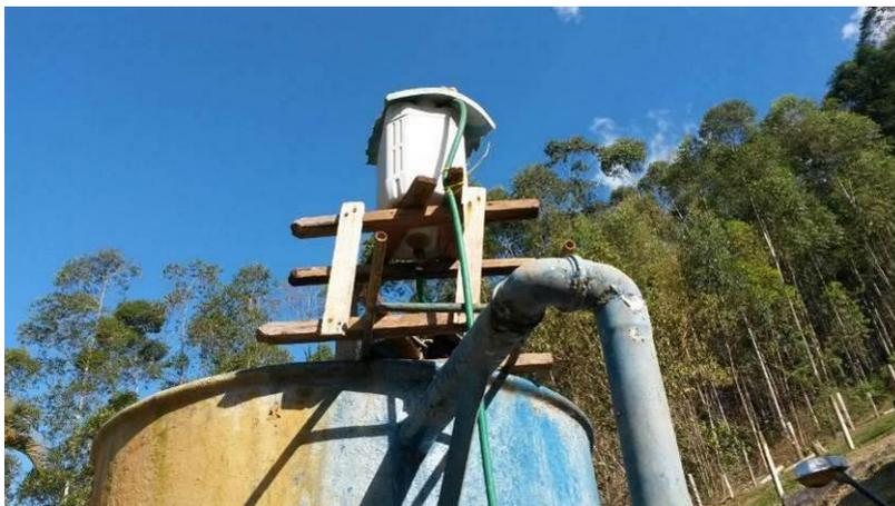
Figura 14 - Instalações inadequadas (tubulações, suporte de apoio ao dosador na chegada) na ETA Ponto Alto.
