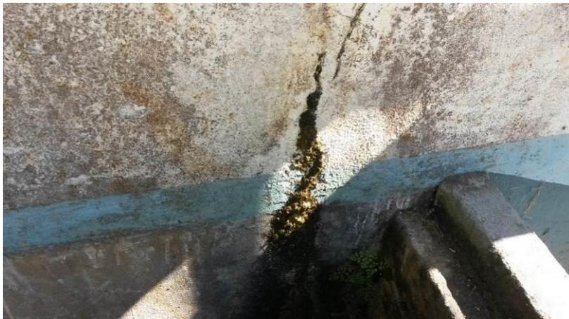
Figura 5 - Há trinca na parede externa do floculador da ETA de Aracê.
