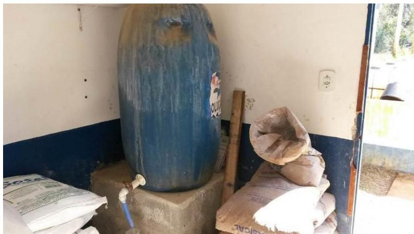
Figura 10 - Ausência de tanque de contenção para Flúor conservado em tambor na ETA Aracê.
