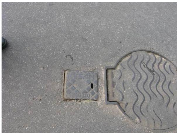
Figura 21 - Descarga localizada à Rua Dom Pedro II, na sede de Domingos Martins, tem tampa com identificação para Esgoto.
