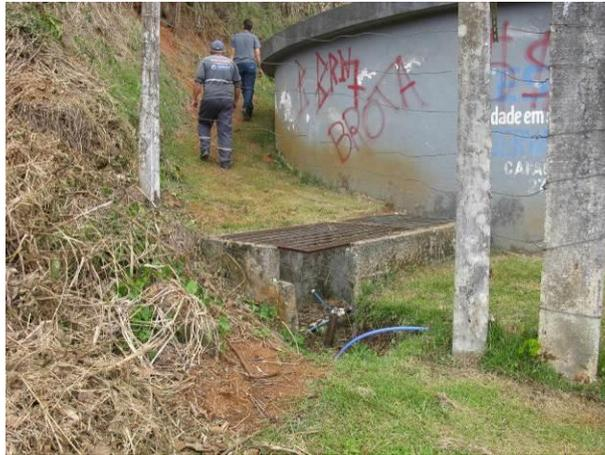
Figura 19 - Há caixa de inspeção quebrada no Reservatório Domingos Martins.
