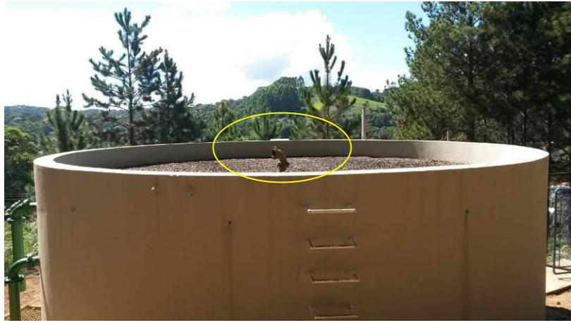
Figura 23 - Duto de ventilação do Reservatório Aracê sem tela de proteção.
