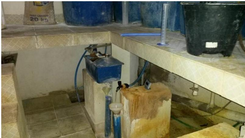
Figura 13 - Faltam identificações nas dosadoras na ETA Ponto Alto.
