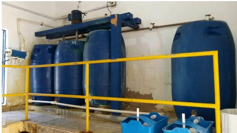
Figura 8 - Faltam identificações nas dosadoras e tanques da ETA Aracê.
