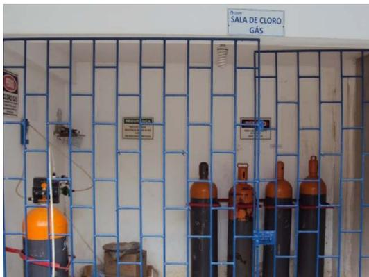
Figura 11: Armazenamento de cloro gasoso
