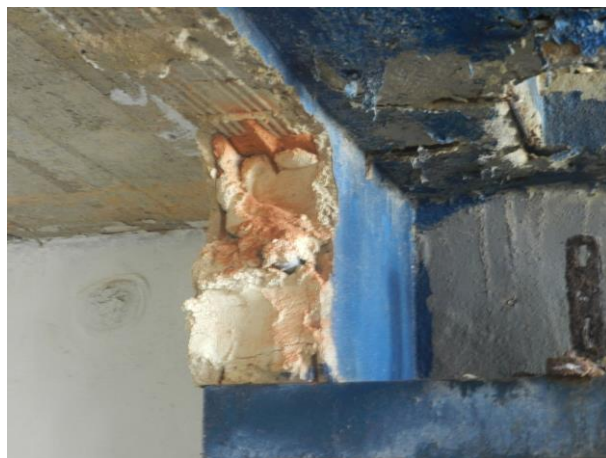
Figura 6 - Paredes sala de dosagem da ETA.
