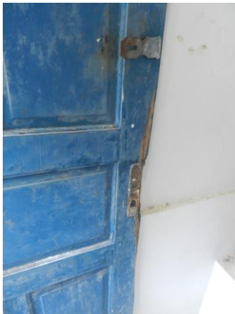
Figura 9 - Porta da sala de produtos químicos.
