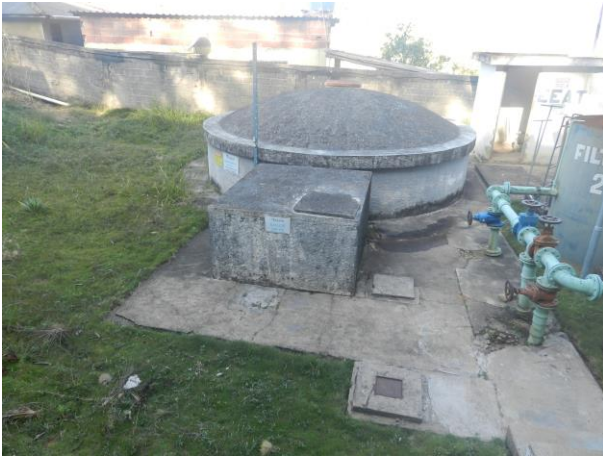
Figura 11 - Tampas do reservatório 01 e tanque de contato.
