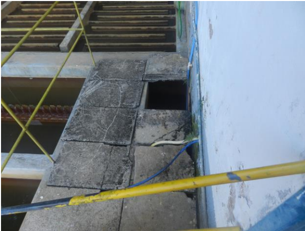
Figura 7 - Tampas próximas aos decantadores.
