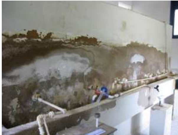
Figura 13 - Paredes da Casa de Química.
