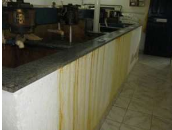
Figura 14 - Tanques da Casa de Química.
