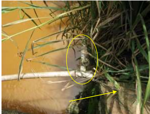
Figura 24 - Descarga de rede localizada próximo à ponte no S.A.A. de Conceição de Castelo.
