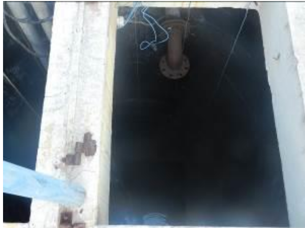
Figura 1 - Poço da EEEB C.
