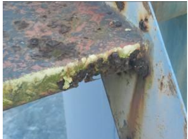
Figura 9 - Escada de acesso ao Reator Uasb + Biofiltro.
