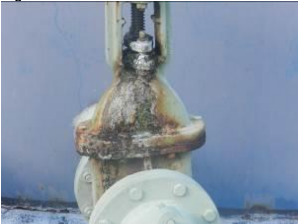
Figura 12 - Registro do reator UASB + Biofiltro.
