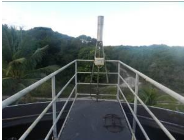
Figura 15 - Queimador de gases.
