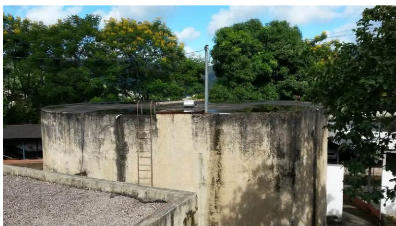
Figura 6 - Reservatório de 730m³ da ETA de Castelo.
