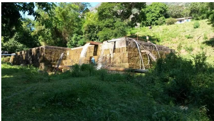
Figura 1- Captação de água Bruta do Rio Caxixe
