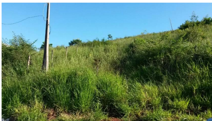
Figura 38 - Ausência de acesso ao Reservatório Santa Mônica
