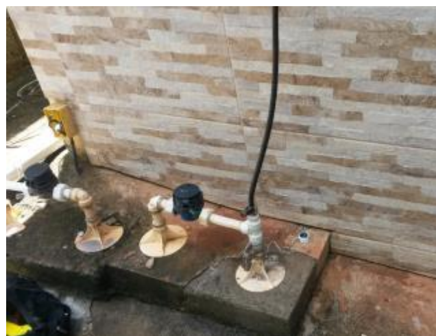
Figura 6 - Equipamento de medição instalado no Ponto 04 - Município de Castelo, ES
