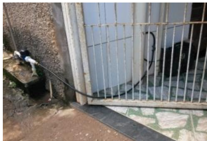
Figura 10 - Equipamento de medição instalado no Ponto 06 – Município de Castelo, ES
