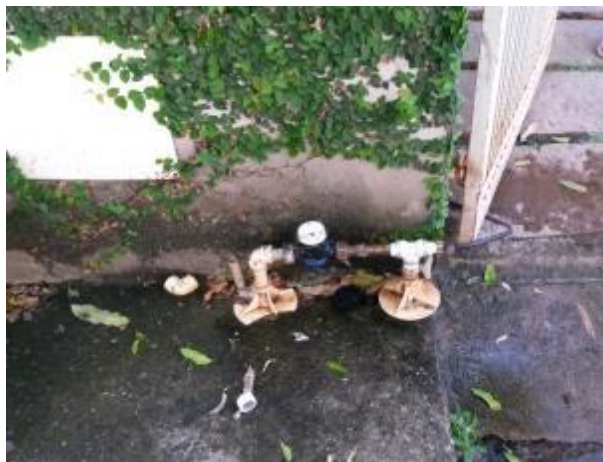
Figura 8 - Equipamento de medição instalado no Ponto 05 – Município de Castelo, ES
