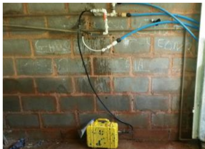
Figura 5 - Equipamento de medição instalado no Ponto 03 - Município de Castelo, ES
