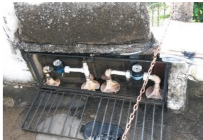
Figura 2 - Equipamento de medição instalado no Ponto 01 - Município de Castelo, ES
