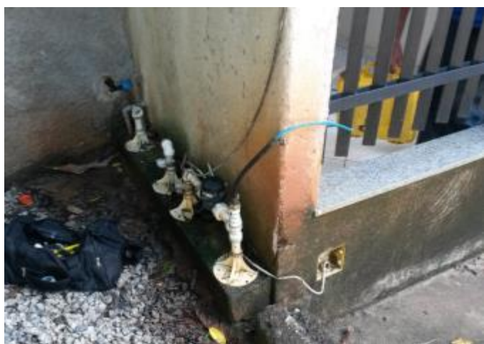
Figura 3 - Equipamento de medição instalado no Ponto 02 - Município de Castelo, ES
