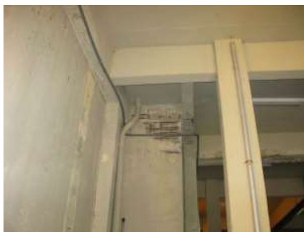
Figura 42 - Sala dos barriletes dos Reservatórios Vale Esperança.
