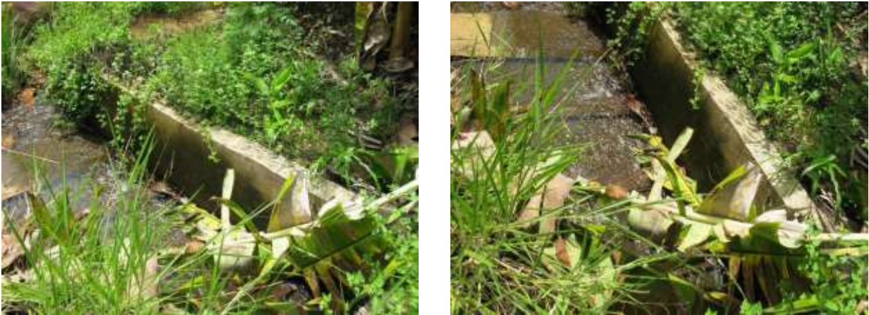
Figura 3 - Caixa de saída da ETA Duas Bocas.
