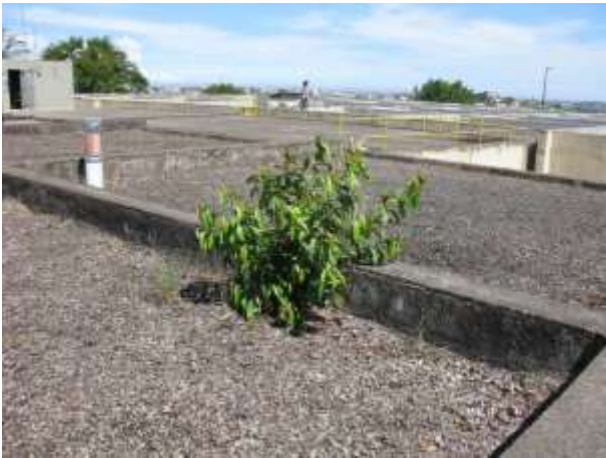
Figura 13 - Laje de cobertura do Reservatório Vale Esperança.
