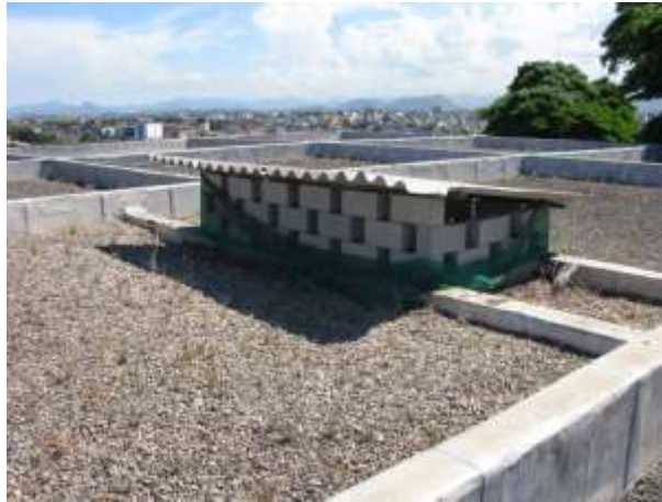
Figura 53 - Reservatório Vale Esperança .
