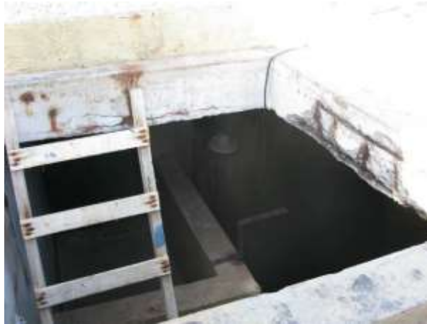
Figura 46 - Reservatório de Alto Lage.
