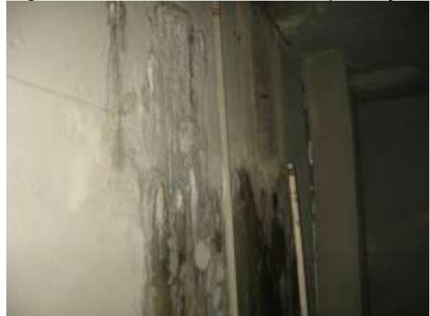
Figura 32 - Reservatório Vale Esperança, parede voltada para sala dos barriletes.
