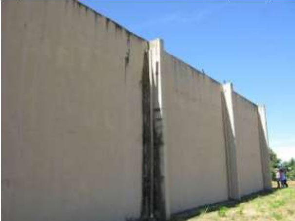
Figura 31 - Reservatório Vale Esperança.
