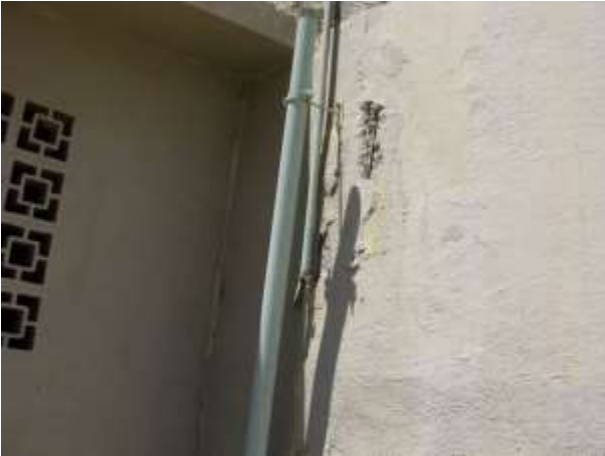
Figura 45 - Reservatório Dido Fontes.
