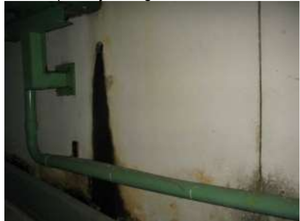
Figura 38 - Nas paredes dos filtros da ETA Vale Esperança Nova.
