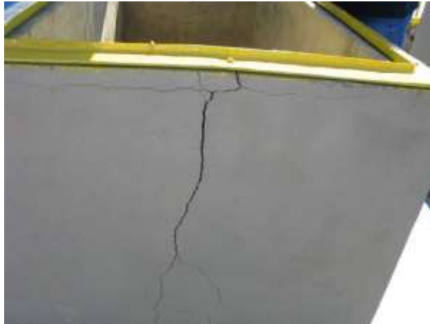
Figura 51 - Caixa de inspeção do Floclador da ETA Vale Esperança Antiga.
