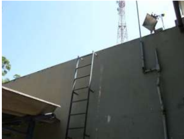
Figura 52 - Escada de acesso ao reservatório para lavagem dos filtros da ETA Vale Esperança.
