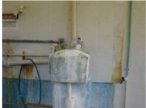
Figura 2 - Dosadoras de produtos químicos na ETA Duas Bocas.
