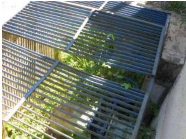
Figura 14 - Caixa de inspeção no Reservatório Nova Rosa da Penha.
