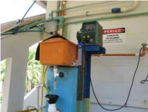
Figura 2 - Dosadoras de produtos químicos na ETA Duas Bocas.
