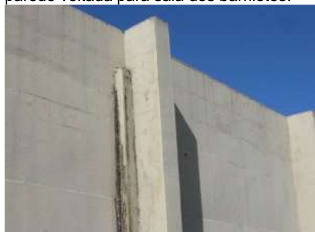
Figura 34 - Reservatório de Alto Lage.
