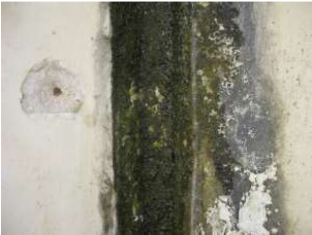
Figura 29 - Reservatório Vale Esperança.
