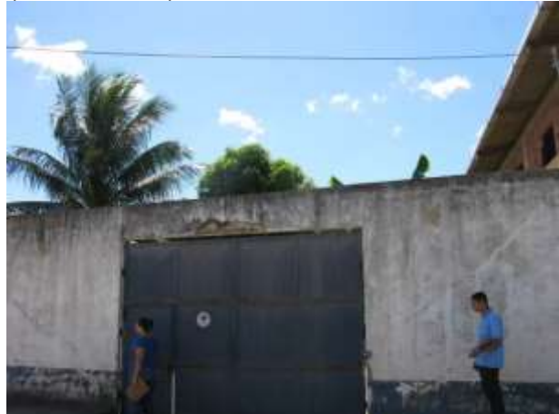
Figura 31 - EEEB Porto Belo.
