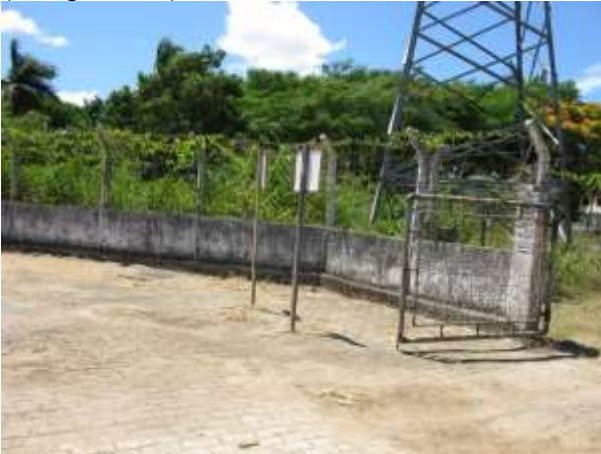
Figura 16 - EEEB Campo Verde, invadida constantemente.
