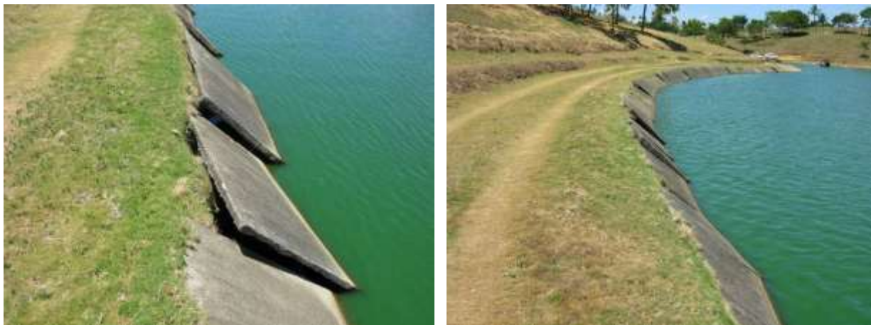
Figura 70 - Rip rap da ETE Nova Rosa da Penha.
