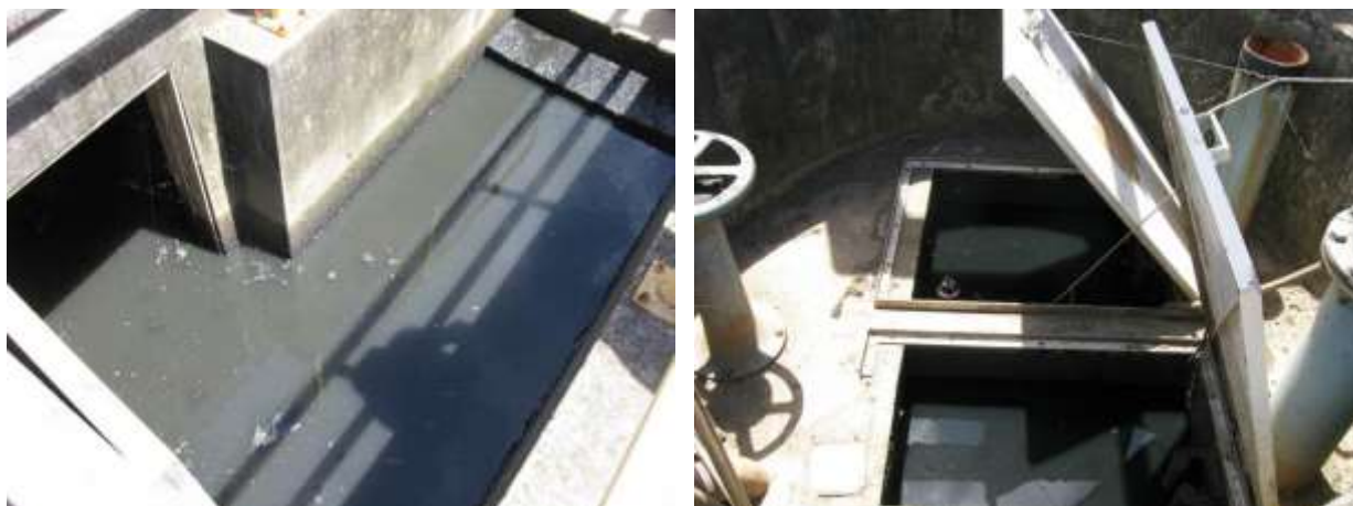
Figura 65 – EEEB Jardim de Alah.
