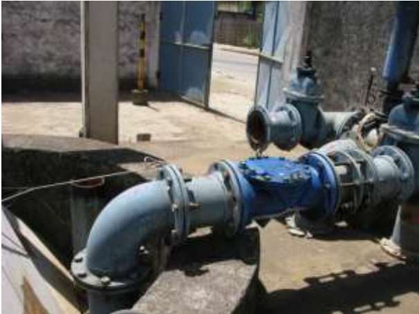
Figura 38 - EEEB Jardim de Alah.
