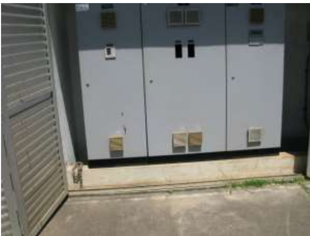
Figura 41 - EEEB Jardim de Alah.
