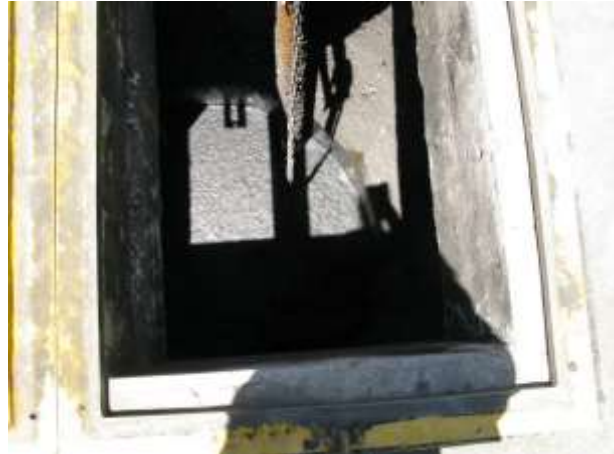
Figura 39 - EEEB Campo Grande.
