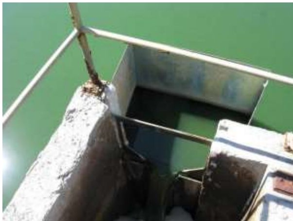
Figura 73 - Guarda corpo na ETE Flexal
