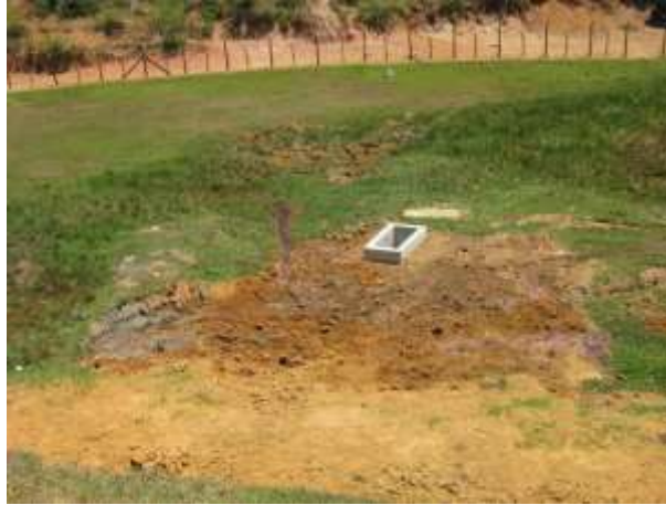
Figura 72 - Solo com água avermelhada próximo à caixa de saída do efluente da ETE Nova Rosa da Penha
