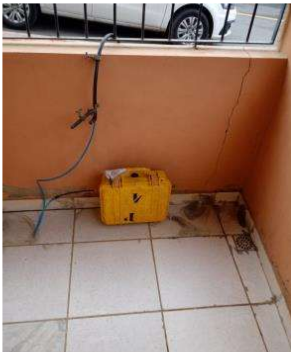
Figura 14 - Equipamento de medição instalado no Ponto 14 – Município de Cariacica, ES
