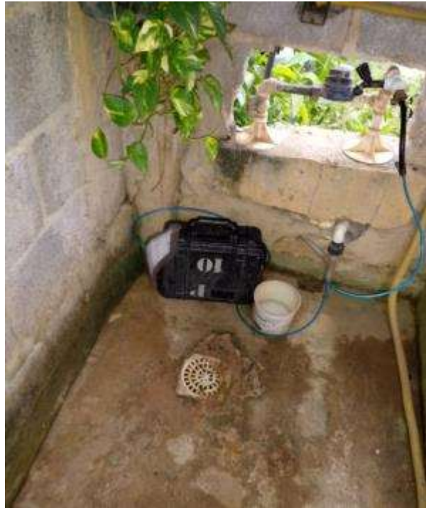
Figura 10 - Equipamento de medição instalado no Ponto 10 – Município de Cariacica, ES
