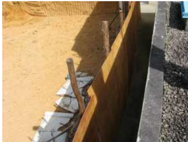
Figura 11 - Escavação do terreno vizinho.
