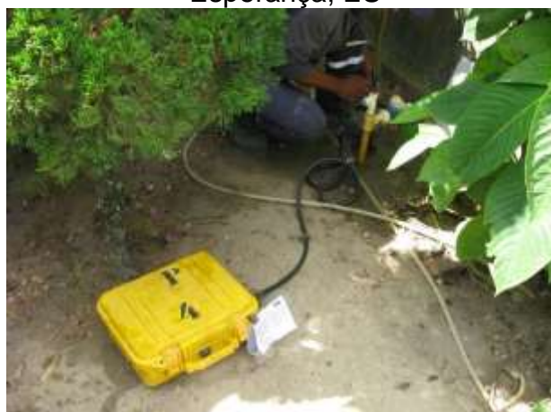
Figura 4 - Equipamento de medição instalado no Ponto 04- Boa Esperança, ES
