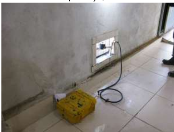
Figura 3 - Equipamento de medição instalado no Ponto 03 - Município de Boa Esperança, ES
