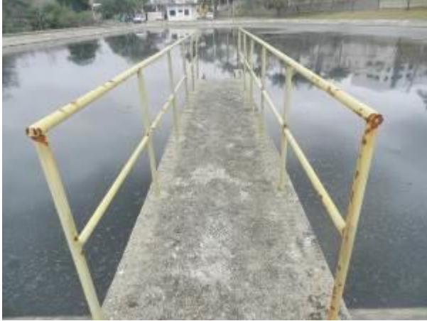
Figura 13 - Guarda Corpo Lagoa da ETE.
