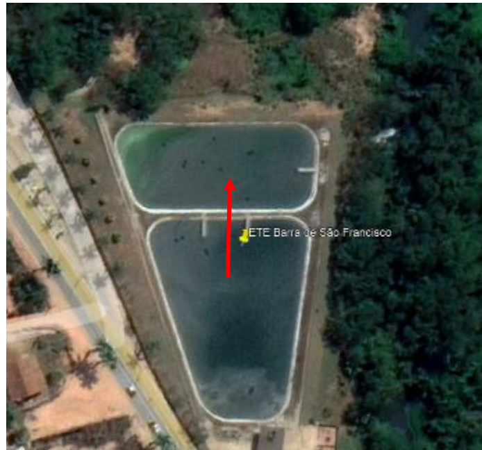
Figura 14 - ETE Barra de São Francisco.
