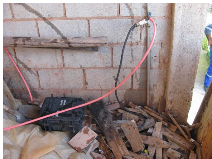
Figura 5 - Equipamento de medição instalado no Ponto 03 - Município de Atílio Vivacqua, ES
