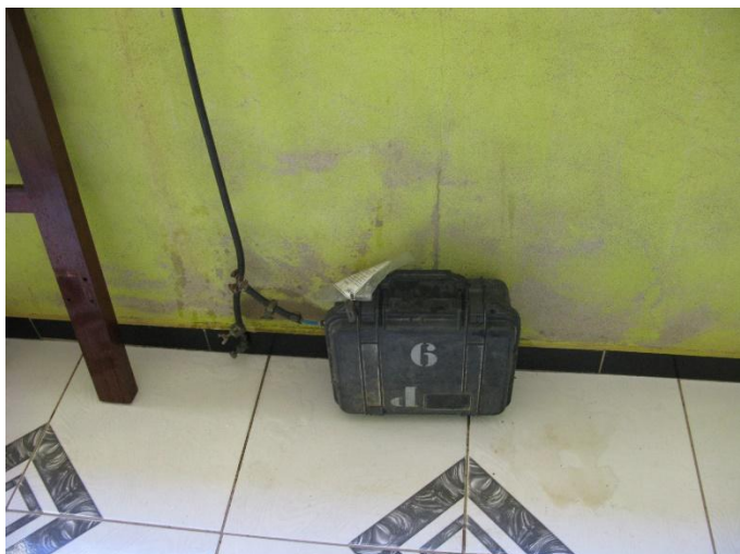
Figura 5 - Equipamento de medição instalado no Ponto 04 – Município de Atílio Vivacqua, ES
