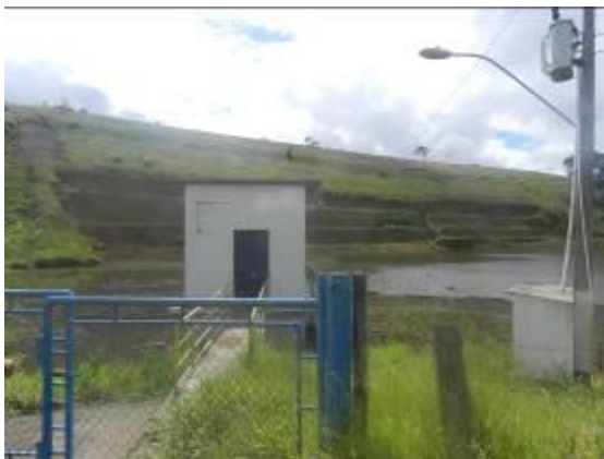
Figura 1 – Captação Alto Rio Novo.
