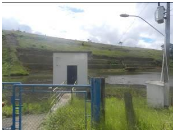
Figura 5 – Captação Alto Rio Novo.
