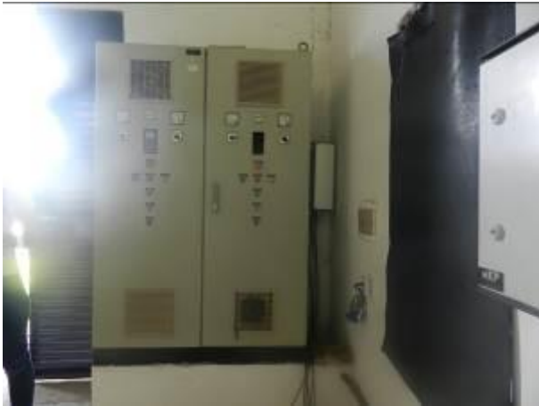
Figura 9 – Captação Alto Rio Novo.
