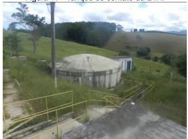
Figura 19 - Reservatório da ETA Alto Rio Novo.
