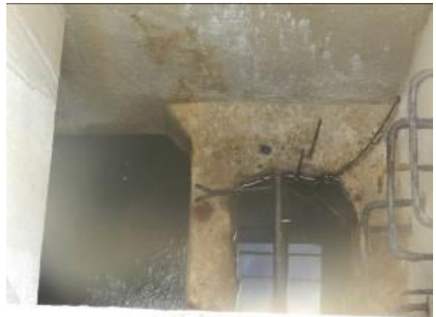
Figura 17 - Tanque de contato da ETA.
