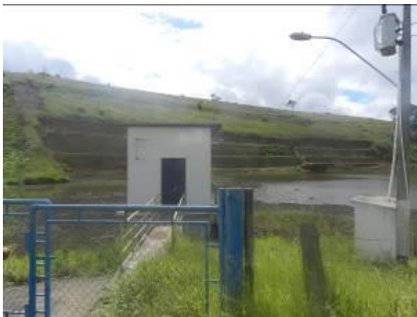
Figura 20 – Captação Alto Rio Novo.
