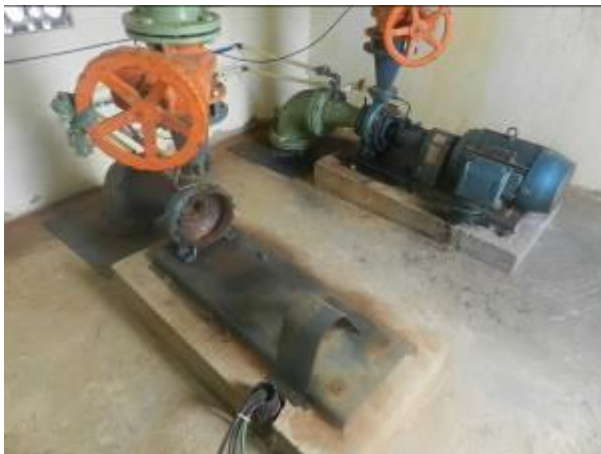
Figura 27 – Captação Alto Rio Novo.
