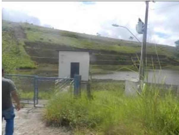
Figura 25 - Captação de Alto Rio Novo (Portão de acesso principal).
