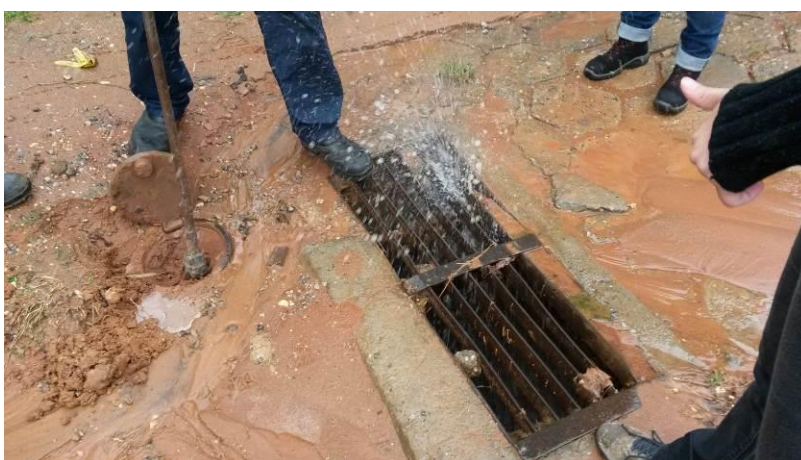
Figura 11 - Descarga na Rua Paulo Saleme em Afonso Cláudio
