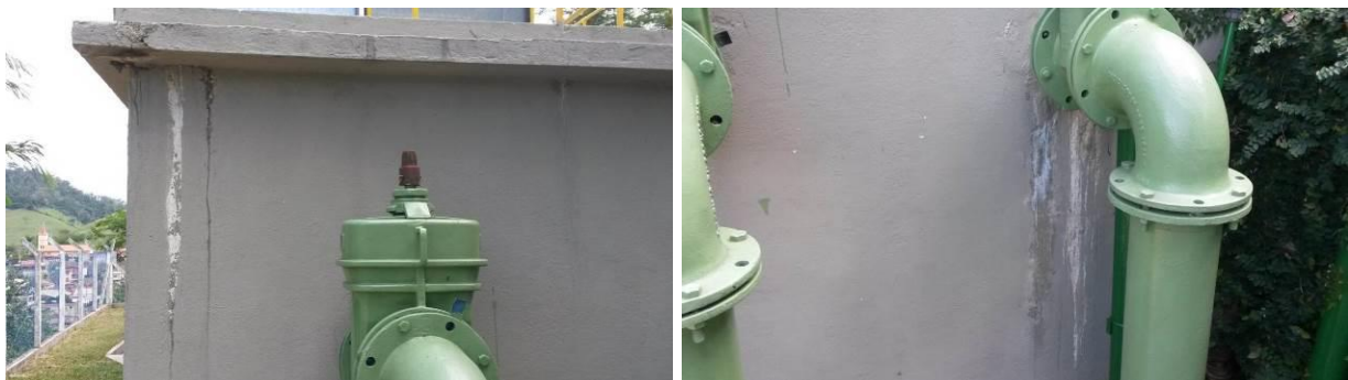
Figura 5 - Paredes externas dos filtros na ETA Serra Pelada.
