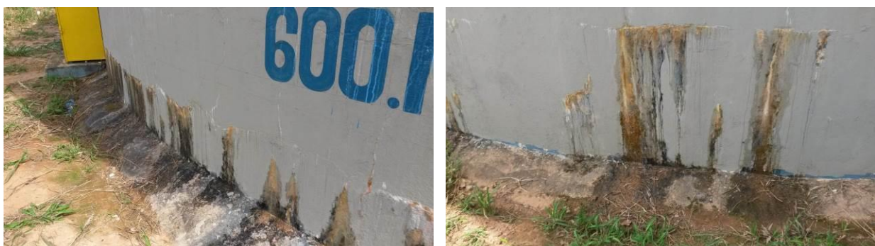
Figura 6 - Reservatório São Vicente do SAA de Afonso Cláudio sede.
