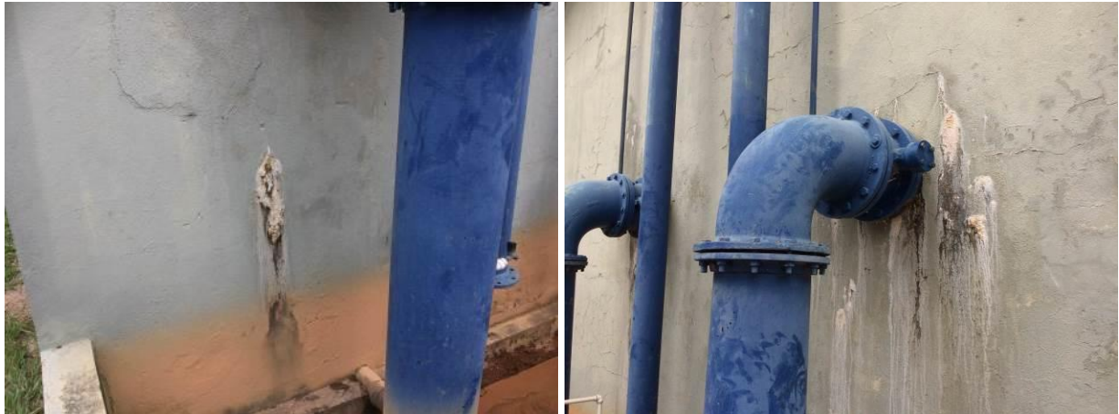
Figura 4 –Paredes externas dos filtros da ETA Afonso Cláudio
