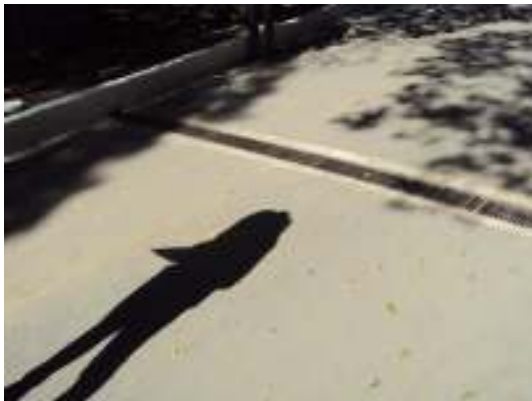
Figura 3 - Canaleta para lavagem das rodas dos caminhões na UGR.
