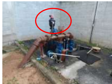
Figura 2 - Ventosa sem vazamento/substituída.
