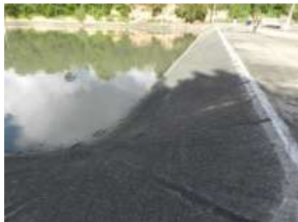
Figura 8 - Talude interno livre de vegetação.
