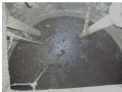
Figura 1 - Poço de sucção.
