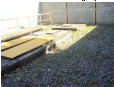
Figura 4 - Área interna da elevatória livre de excesso de vegetação.
