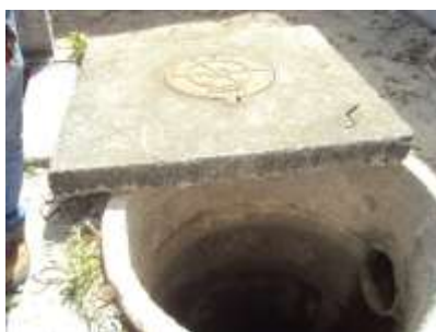
Figura 4 - Caixa de recepção de esgoto com tampa.
