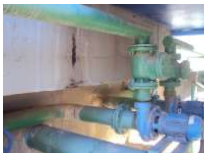
Figura 2 - Infiltração nos biofiltros e decantadores solucionada.
