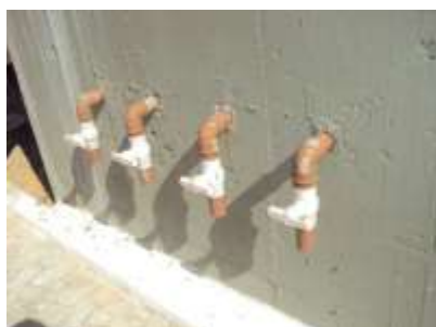
Figura 1 - Infiltração no reator eliminada.
