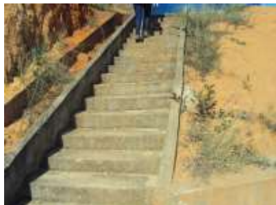
Figura 3 - Escada de acesso às comportas.
