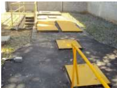
Figura 2 - Poço de sucção tampado e retirada do excesso de vegetação.
