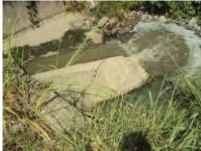
Figura 2 - Ponto de lançamento do efluente, com pouca espuma (Foi informado durante a vistoria que serão realizadas intervenções no ponto de lançamento final).
