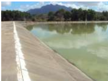
Figura 1 - Talude interno livre de vegetação.
