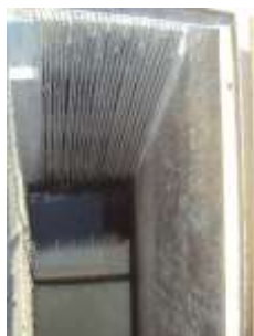
Figura 1 - Gradeamento limpo.
