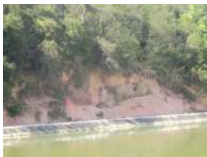
Figura 3 - Talude parcialmente exposto em área anexa (processo de proteção do talude iniciado – folha 35).
