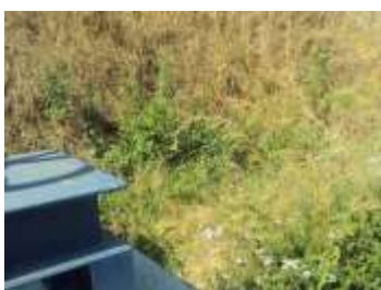
Figura 1 - Permanência de vegetação no entorno das caixas, entretanto as mesmas não serão retiradas a fim de se evitar erosão no local.
