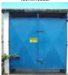
Figura 3 - Sinalização de risco de choque elétrico implantada.
