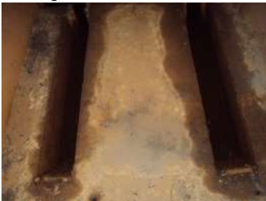
Figura 3 – Caixa de areia após limpeza.
