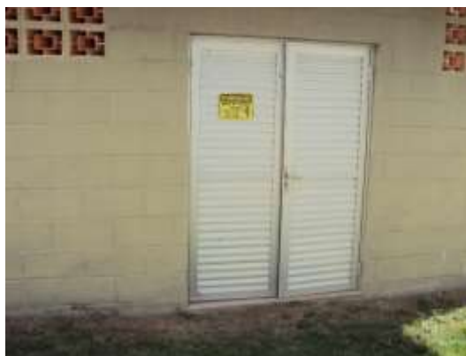
Figura 1 – Painel de controle com sinalização de risco de choque elétrico implantada.
