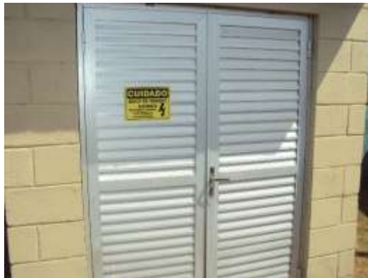
Figura 3 – Painel de controle com sinalização de risco de choque elétrico implantada.
