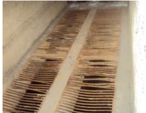
Figura 2 – Mecanismo de remoção de sólidos grosseiros após limpeza.
