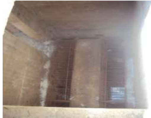
Figura 2 – Caixa de areia após limpeza.
