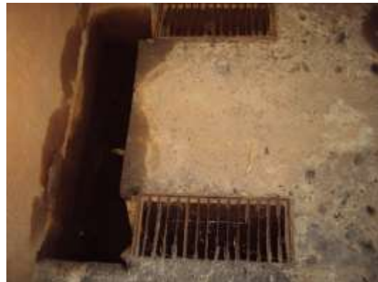
Figura 2 – Caixa de areia após limpeza.
