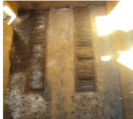
Figura 2 – Gradeamento após limpeza.
