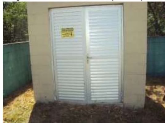
Figura 4 – Painel de controle com sinalização de risco de choque elétrico implantada.
