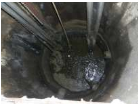
Figura 26 - Ausência de bomba reserva da EEEB da ETE Vivendas de Pedra Azul.
