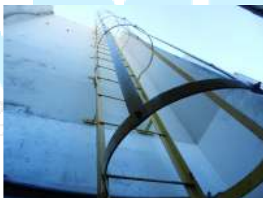
Figura 5 - Acesso ao reservatório elevado.
