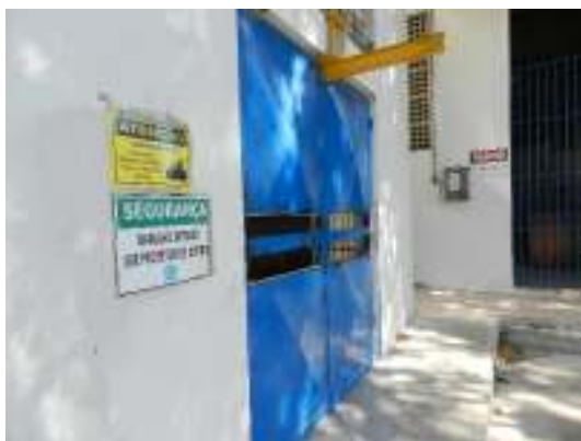
Figura 14 - Sinalização de segurança.
