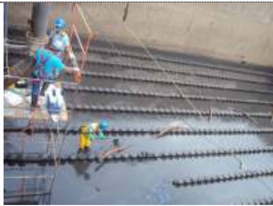
Figura 5 – Manutenção no Tanque B da ETE Araçás.
