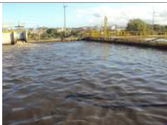
Figura 1 - Tanque anóxico de chegada do esgoto bruto à ETE Araçás.
