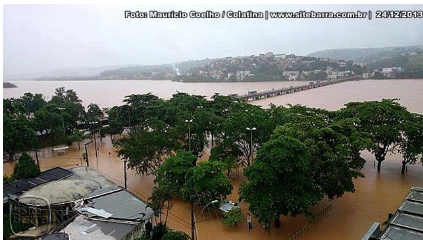
Figura 3.16: Vista panorâmica da situação do município nas chuvas de dezembro de 2013.
