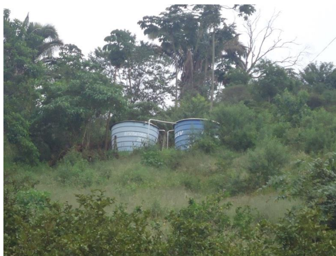
Figura 9 - Reservatórios de abastecimento público - Vila da Amizade (capacidade - 20 m³ cada)
