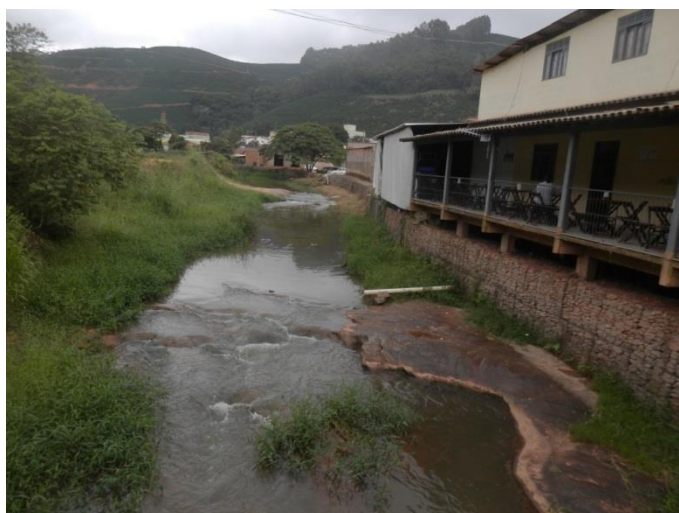
Figura 31 - Visão de montante da ponte 2.
