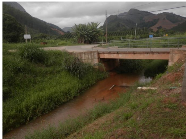
Figura 29 - Perfil lateral da ponte 1
