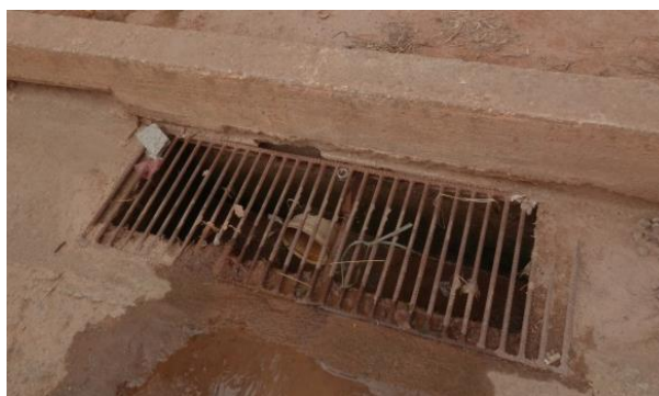
Figura 42 - Detalhe da rede de drenagem
