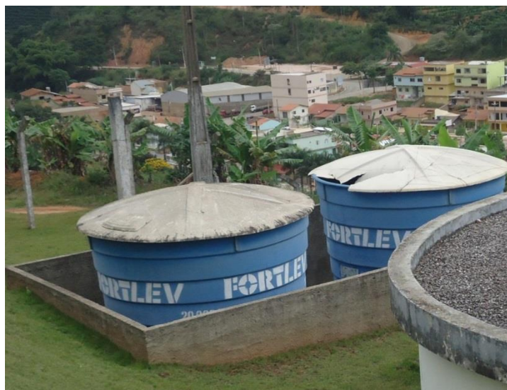
Figura 4 - Reservatórios de abastecimento público (capacidade - 20m 3 cada)
