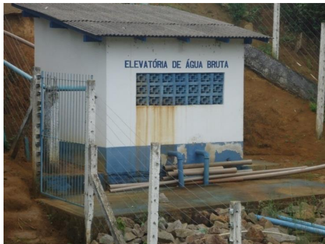
Figura 5 - Estação elevatória de água bruta - córrego Oliveira
