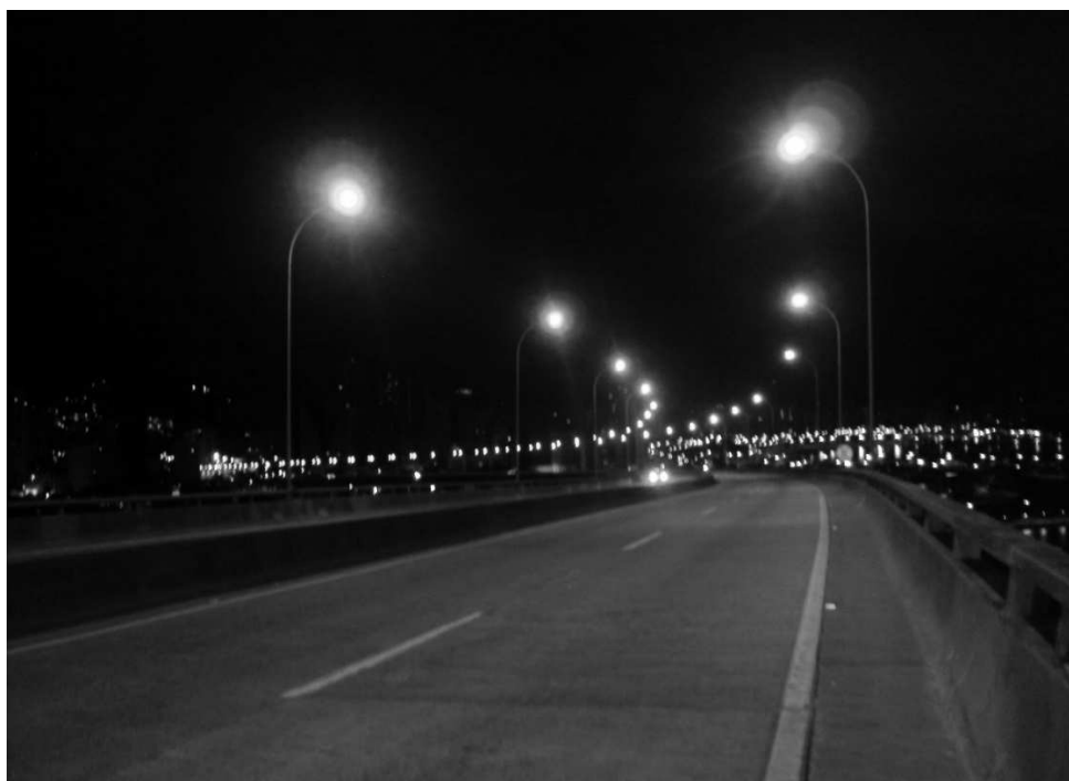
Fiscalização Periódica – Terceira Ponte
