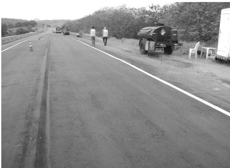
Fiscalização Periódica - Conserva Especial do Pavimento
