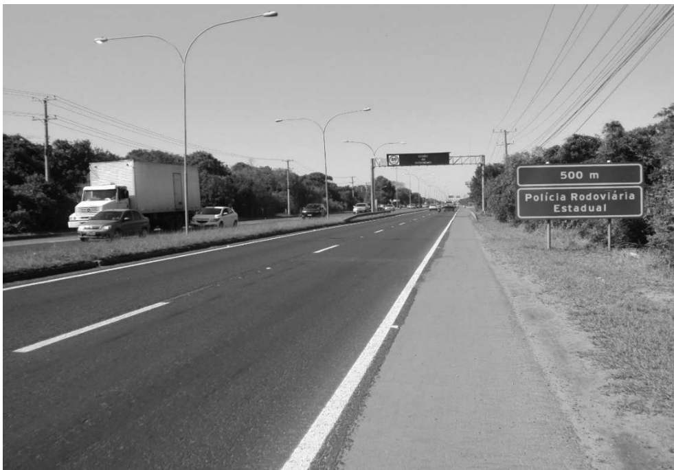
Instalação de novo Painel de Mensagem Variável (PMV) – Barra do Jucu
