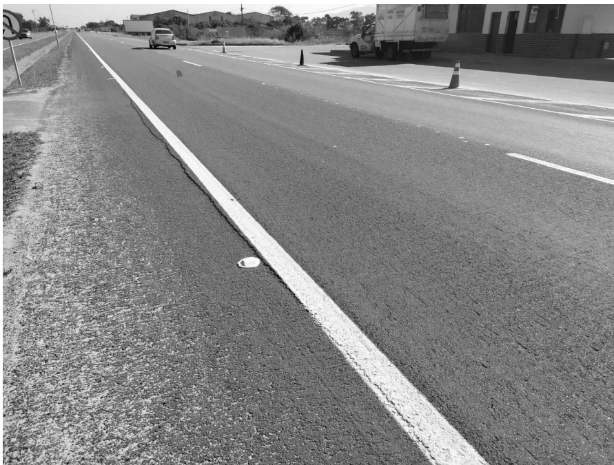
Fiscalização Periódica – Conserva Especial do Pavimento
