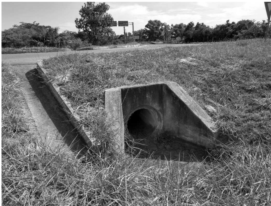
Fiscalização Periódica – Sistema de drenagem
