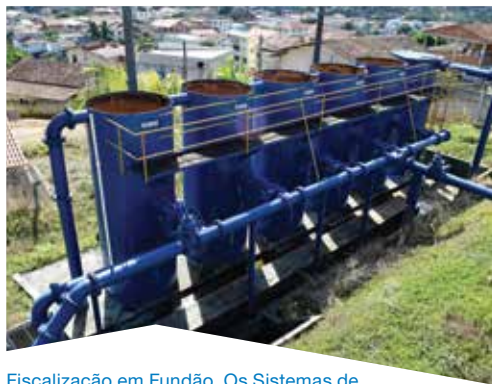
Fiscalização em Fundão. Os Sistemas de Abastecimento da Sede e de Timbuí foram inspecionados.
