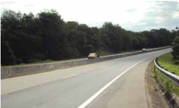
Fiscalização Periódica - Pavimento e Sinalização Horizontal.
