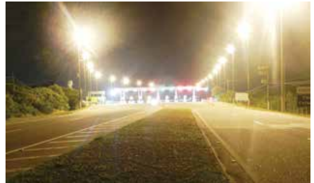
Fiscalização Periódica - Iluminação.
