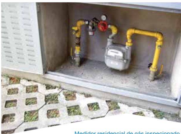
Medidor residencial de gás inspecionado.
