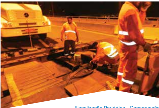
Fiscalização Periódica - Conservação Especial da Terceira Ponte.
