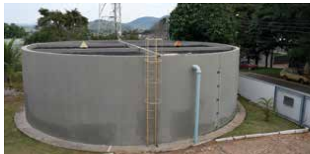
Fiscalização periódica em São José do Calçado. O Sistema de Abastecimento de Água e Plano Municipal de Saneamento foram acompanhados.
