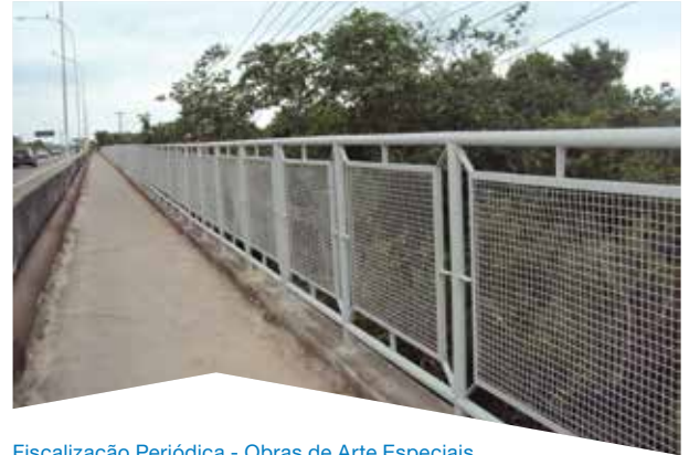
Fiscalização Periódica - Obras de Arte Especiais.
