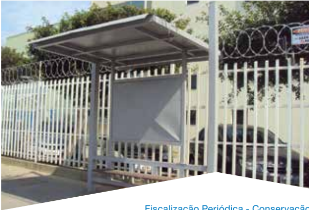
Fiscalização Periódica - Conservação dos Abrigos nos Pontos de Ônibus.
