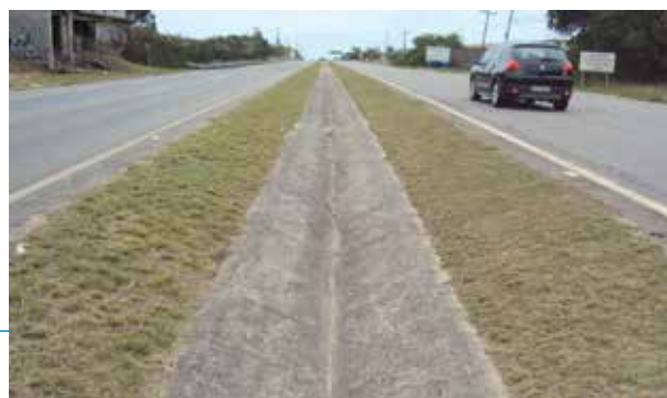
Fiscalização Periódica - Drenagem.
