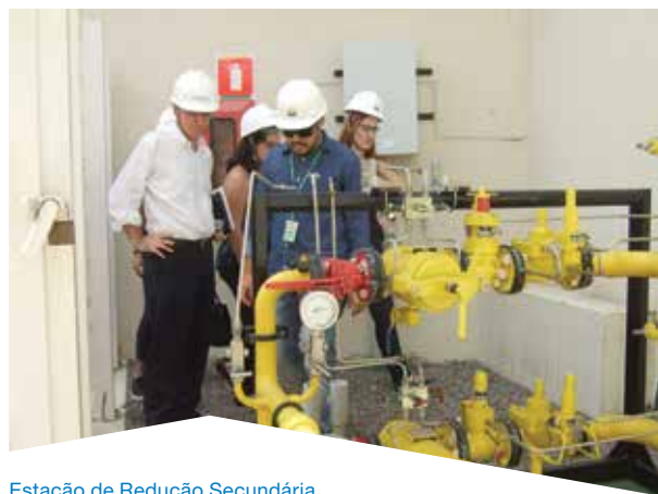
Estação de Redução Secundária.
