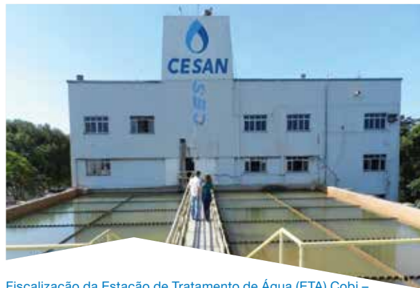
Fiscalização da Estação de Tratamento de Água (ETA) Cobi – Vila Velha para atender à demanda do Ministério Público.
