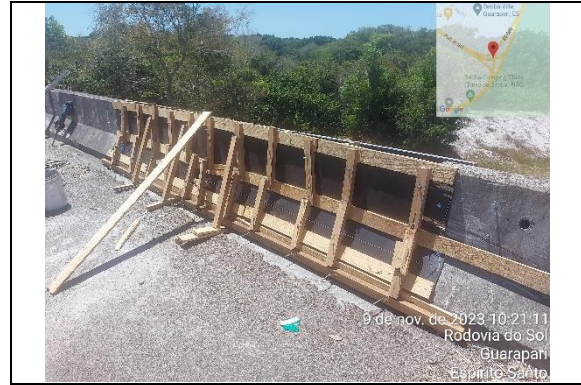
Fotos 15 e 16 – Acompanhamento de recomposição de barreira de concreto sobre viaduto.
