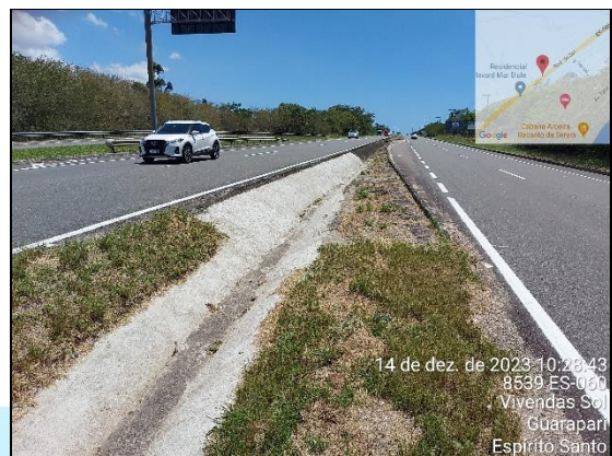
Fotos 11 e 12 – Recomposição das canaletas de drenagem superficial.
