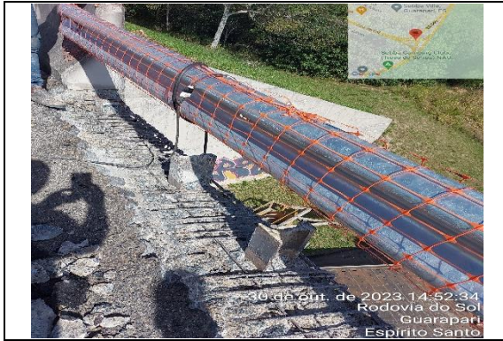
Fotos 15 e 16 – Acompanhamento de recomposição de barreira de concreto sobre viaduto.
