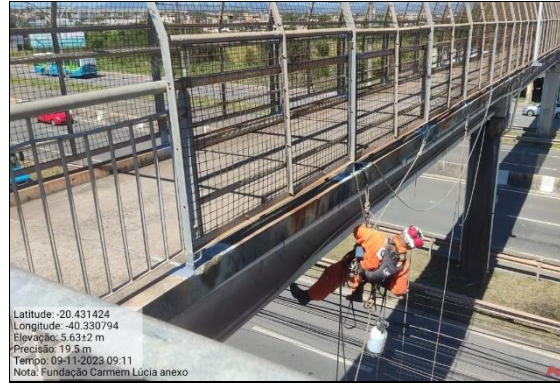
Fotos 03 e 04 – Constatação de telas avariadas e colaborador da Rodosol realizando a manutenção de passarela.
