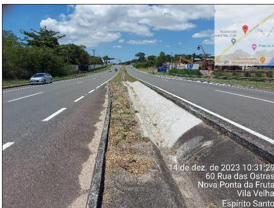
Fotos 11 e 12 – Recomposição das canaletas de drenagem superficial.
