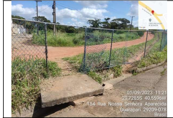
Fotos 09 e 10 – Fiscalização dos serviços de Rotina da faixa de domínio (alambrado danificado).
