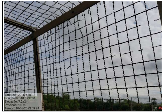
Fotos 03 e 04 – Fiscalização das OAE's (Obras de Arte Especiais - Grades danificadas).
