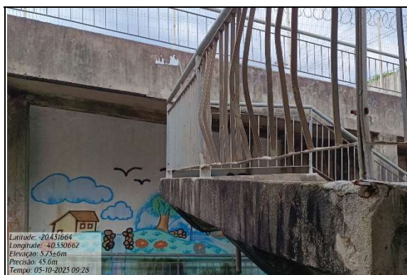
Fotos 17 e 18 – Fiscalização das OAE's (Obras de Arte Especiais - Estrutura metálica danificada).
