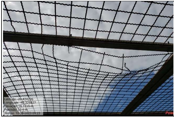
Fotos 03 e 04 – Fiscalização das OAE's (Obras de Arte Especiais - Grades danificadas).
