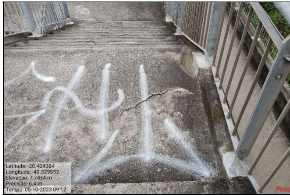
Fotos 15 e 16 – Fiscalização das OAE's (Obras de Arte Especiais - Deslocamento de concreto).
