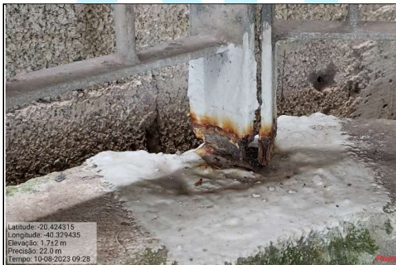
Fotos 07 e 08 – Fiscalização das OAE's (Obras de Arte Especiais - Processo de corrosão).
