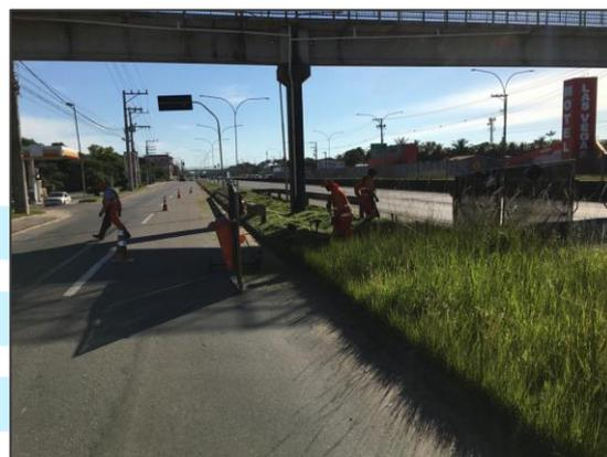
Fotos 02 e 03 – Fiscalização dos serviços periódicos de segurança viária e de rotina (substituição de defesa metálica e poda manual, respectivamente).
